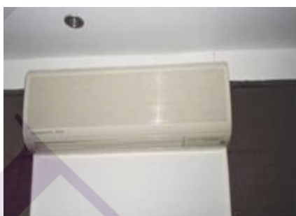
ภาพที่ 3.29 ระบบปรับอากาศชนิด แยกส่วน (Spilt Type)
