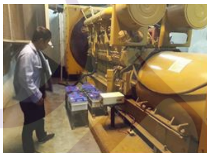
ภาพที่ 3.27 ระบบเครื่องกำเนิดไฟฟ้าสำรอง ชนิดเครื่องยนต์ดีเซล ขนาด 1600 KVA
