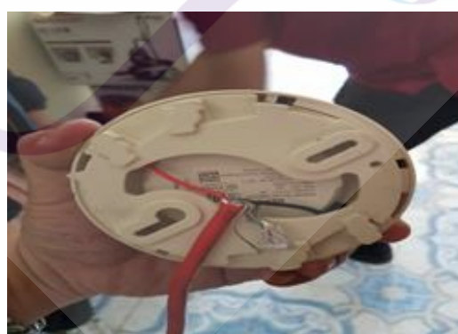
ภาพที่ 3.13 การเชื่อมต่ออุปกรณ์ตรวจจับควันอัตโนมัติ (Smoke Detector) ตัวทดสอบบริเวณพื้นที่ทางเดินส่วนกลางชั้น 22 อาคารพักอาศัย 8
