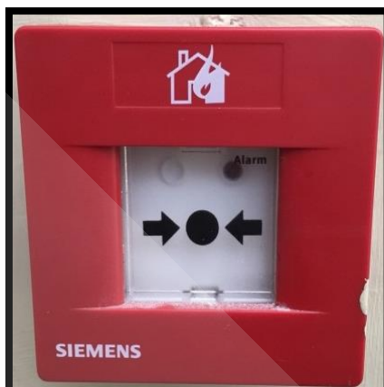
ภาพที่ 3.48 อุปกรณ์แจ้งเตือนด้วยมือ (Manual Call Point)
