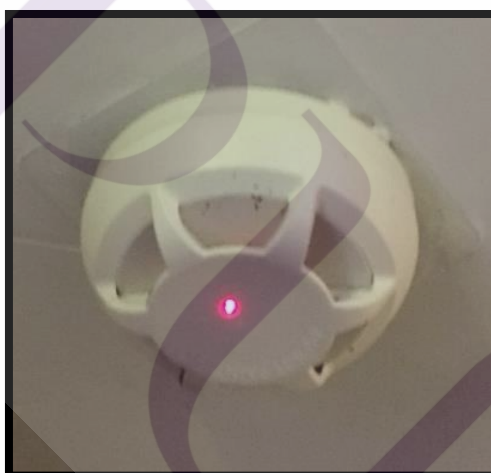
ภาพที่ 3.47 อุปกรณ์ตรวจจับความร้อน (Heat Detector)
