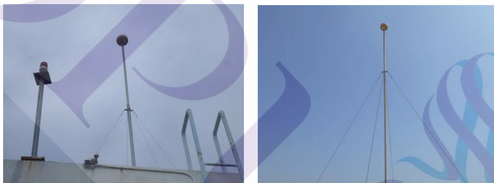
ภาพที่ 3.41 ระบบป้องกันฟ้าผ่าชนิดสร้างลำประจุ
