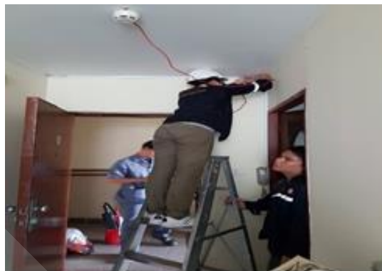
ภาพที่ Error! No text of specified style in document..16 ติดตั้งอุปกรณ์ตรวจจับควันอัตโนมัติ (Smoke Detector) ตัวทดสอบภายในห้องชุดฯ
