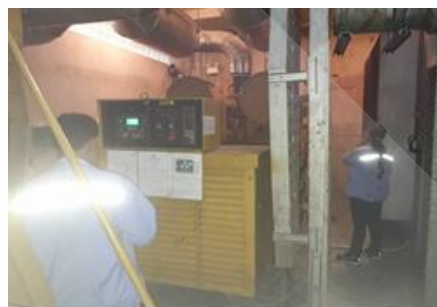
ภาพที่ 3.27 ระบบเครื่องกำเนิดไฟฟ้าสำรอง ชนิดเครื่องยนต์ดีเซล ขนาด 1600 KVA
