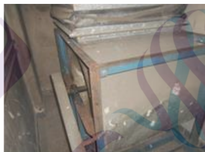
ภาพที่ 3.30 ระบบระบายควัน และควบคุมการแพร่กระจายควัน ชนิดพัดลมอัดอากาศ (Pressurize Air Fan)
