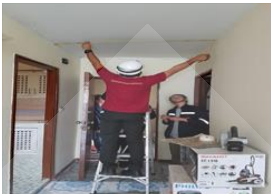
ภาพที่ Error! No text of specified style in document..16 ติดตั้งอุปกรณ์ตรวจจับควันอัตโนมัติ (Smoke Detector) ตัวทดสอบภายในห้องชุดฯ
