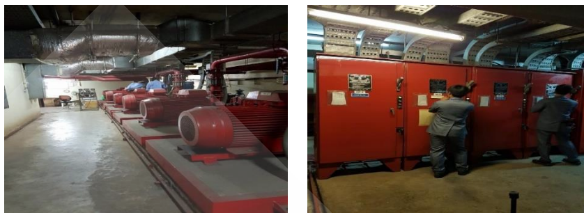
ภาพที่ 3.37 เครื่องสูบน้ำดับเพลิง ชนิดแรงเหวี่ยงหนีศูนย์กลาง
