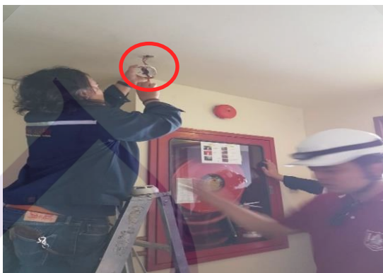
ภาพที่ 3.12 การเปลี่ยนตัวอุปกรณ์ตรวจจับความร้อน (Heat Detector) ที่ติดตั้งอยู่ที่บริเวณพื้นที่ส่วนกลางออก
