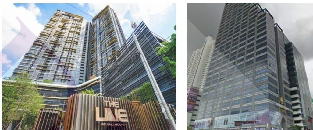
ภาพที่ 2.12 เปรียบเทียบงาน Façade ระหว่าง ระบบงานแผง Window Wall กับ Curtain Wall
