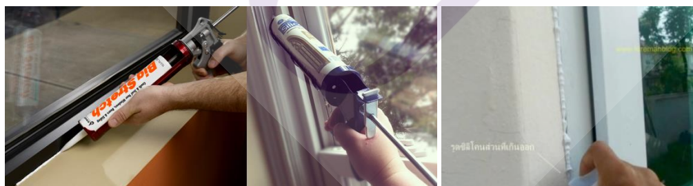
ภาพที่ 3.4 การยิงวัสดุยาแนวที่ใหญ่เกินไปทำให้เกิดความสูญเสีย
