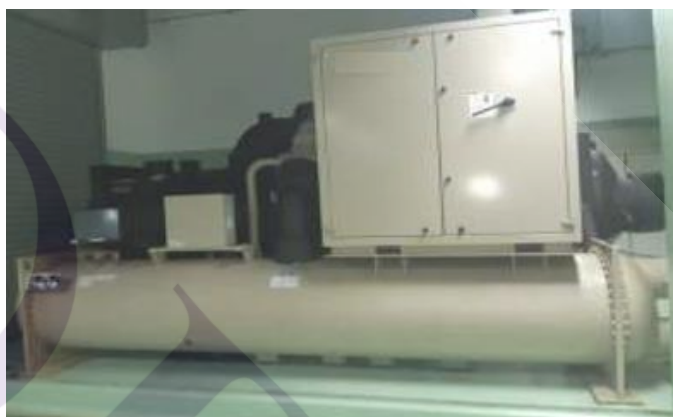
ภาพที่ 3.15 ลักษณะเครื่องทำน้ำเย็น (Chiller) ขนาด 500 ตัน
