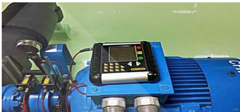
ภาพที่ 4.11 การตรวจเช็ค Alignment ของปั๊ม
