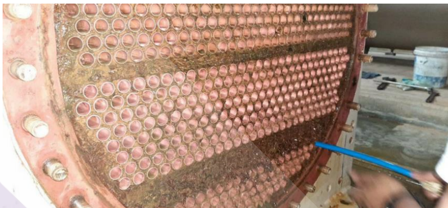
ภาพที่ 4.19 การตรวจเช็คทำความสะอาดท่อคอนเดนเซอร์
