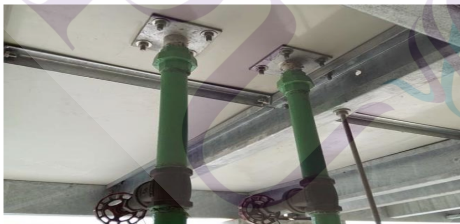
ภาพที่ 4.6 การตรวจเช็คการรั่วซึมของท่อน้ำเติม
