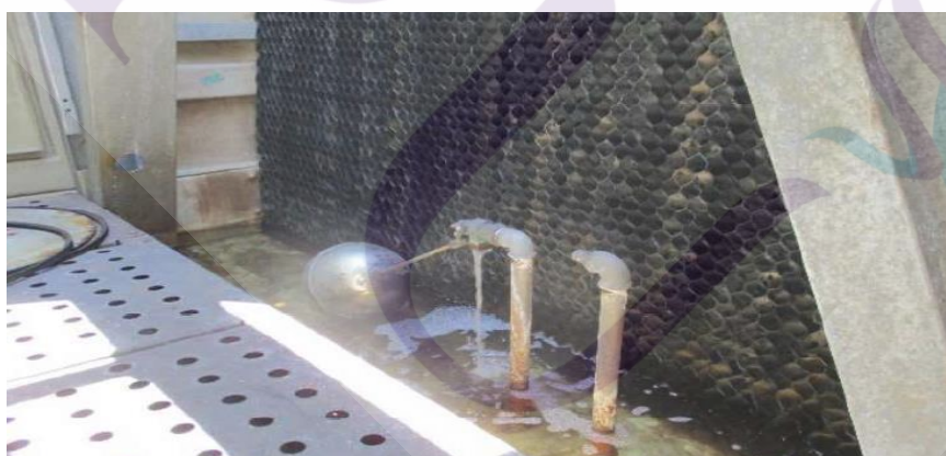
ภาพที่ 4.8 การตรวจเช็คคลุกเคลยเติมน้ำอัดโนมิติและความสะอาดฟิลเลอร์
