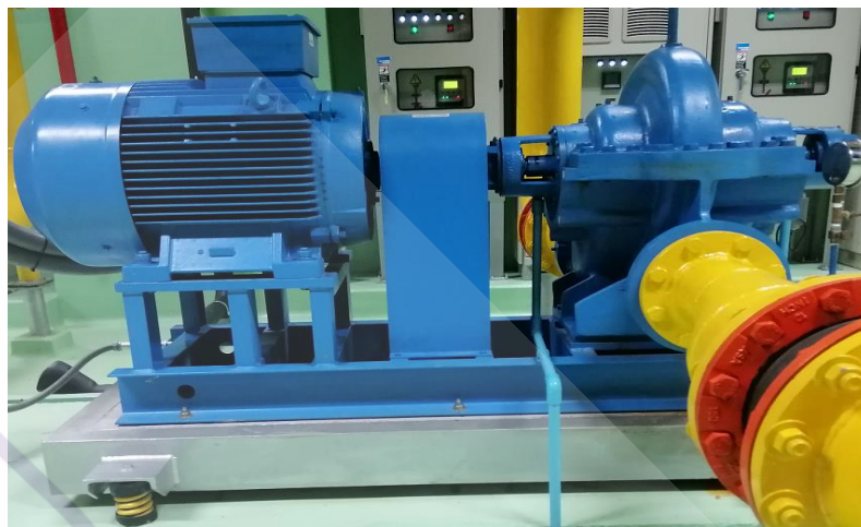
ภาพที่ 3.9 ลักษณะปั้มน้ำคอนเดนเซอร์ขนาด 75 แรงม้า
