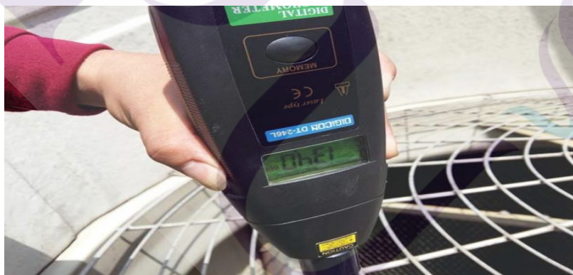
ภาพที่ 4.4 การตรวจเช็คความเร็วของพัดลมระบายอากาศ
