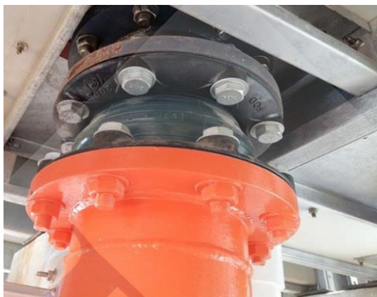
ภาพที่ 4.7 การตรวจเช็คการรั่วของท่อน้ำเข้าออก
