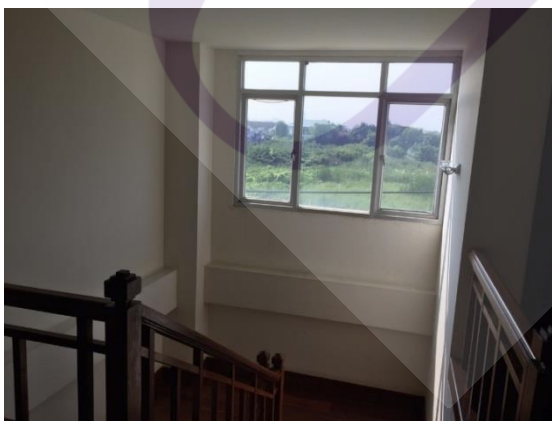
ภาพที่ 4.29 แสดงลักษณะของกระจกที่ไม่มีกันสาดหรือส่วนที่ยื่นออกไปเพื่อบังแสงอาทิตย์
