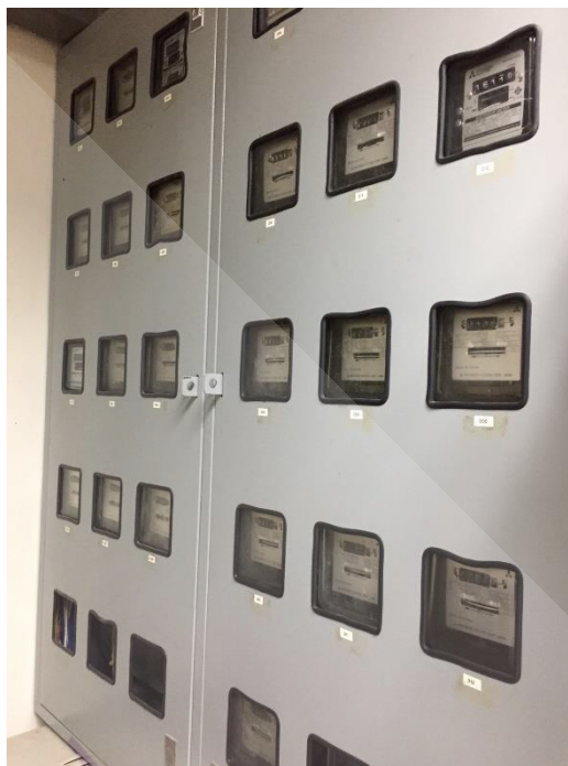
ภาพที่ 4.22 แสดงมิเตอร์ไฟฟ้าย่อยของแต่ละห้องพัก
