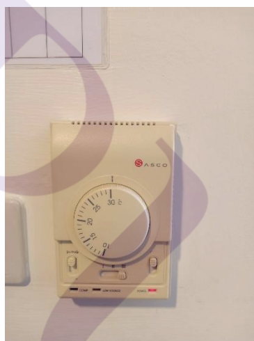
ภาพที่ 4.47 แสดงเครื่องปรับอุณหภูมิแบบอิสระ
