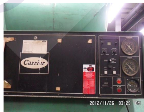
รูปที่ 3.8 เครื่อง Chiller ของ Carrier ขนาด 500 TR และ Control Board
