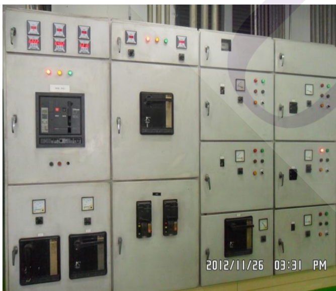
รูปที่ 3.6 ตู้ควบคุมระบบไฟฟ้าของระบบปรับอากาศ
