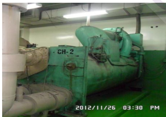
รูปที่ 3.8 เครื่อง Chiller ของ Carrier ขนาด 500 TR และ Control Board
