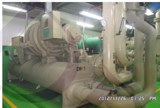
รูปที่ 3.7 เครื่อง Chiller ของ Trane ขนาด 500 TR และ Control Monitor
