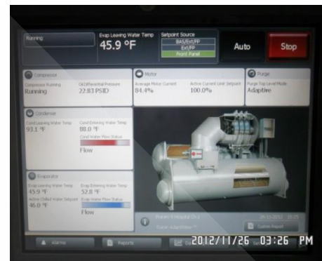
รูปที่ 3.7 เครื่อง Chiller ของ Trane ขนาด 500 TR และ Control Monitor
