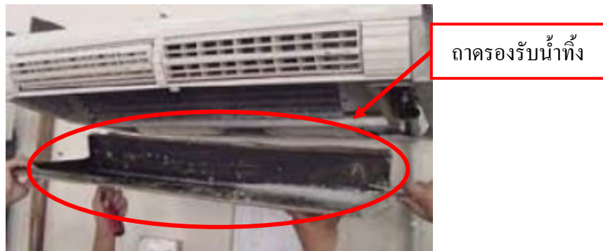
ภาพที่ 3.7 ถาดรองรับน้ำทิ้ง (Condensate Tray)
