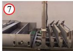
เสร็จสิ้นกระบวนการล้าง คอยล์เย็น
