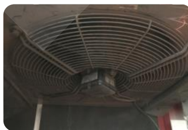
ภาพที่ 2.4 แสดงลักษณะอุปกรณ์ระบายความร้อนหลังการอัดอากาศ
