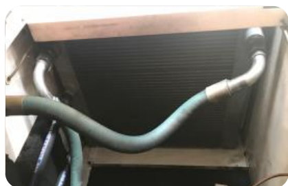
ภาพที่ 2.4 แสดงลักษณะอุปกรณ์ระบายความร้อนหลังการอัดอากาศ
