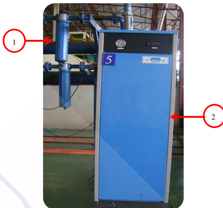
ภาพที่ 2.6 แสดงลักษณะตัวกรองอากาศภายในท่อและตัวทำให้อากาศแห้ง
