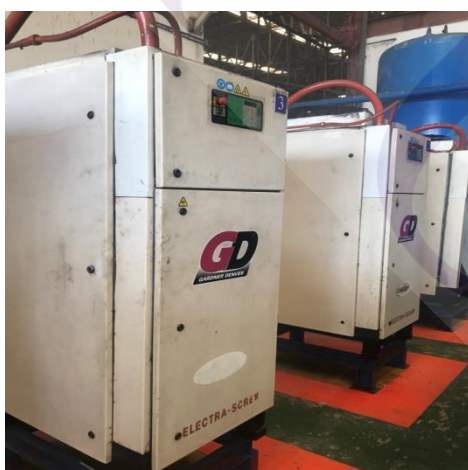
ภาพที่ 2.2 แสดงลักษณะเครื่องอัดอากาศแบบ โรตารีสกรู
