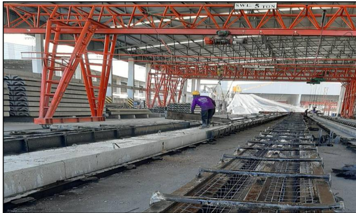
ภาพที่ 3.13 การถอดแบบข้างและตัดลวดอัดแรงทำการถอดแบบข้างเมื่อเสาเข็มที่ผลิตแข็งตัวแล้ว
