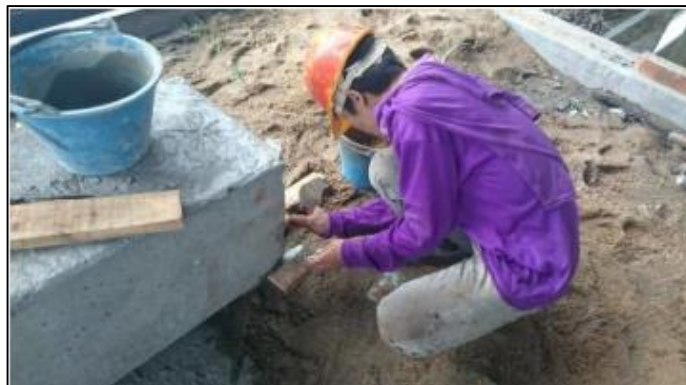
ภาพที่ 3.14 การซ่อมแซมผิว ใช้ซีเมนต์พิเศษชนิดไม่หดตัว (Non-Shrink Cement) ในการซ่อมแซมผิว
