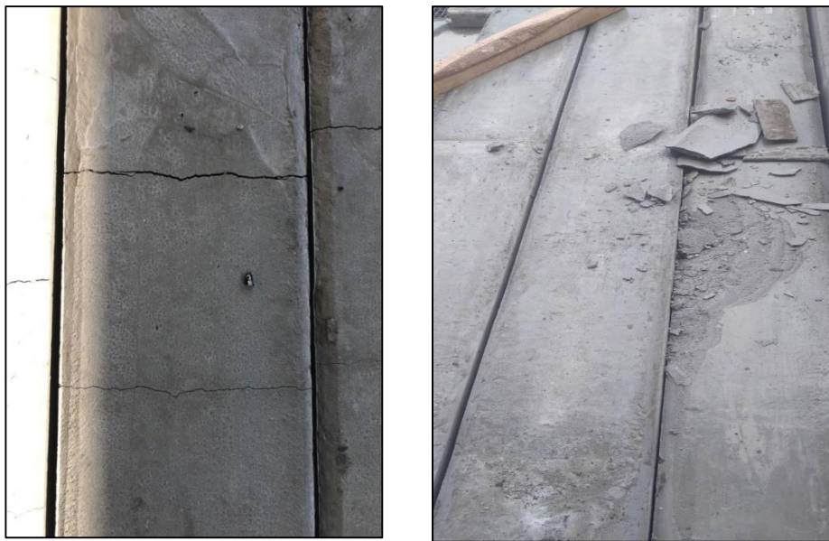
ภาพที่ 3.3 เสาค้มน้ผิวหน้ามีรอยร้าวแตก ปัญหา “รอยแตกร้าว”
