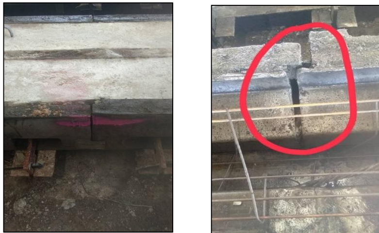
ภาพที่ 3.6 รอยต่อแบบที่ผิวเสาค้ำ
