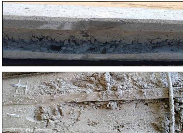
ภาพที่ 3.7 การสูญเสียของคอนกรีตระหว่างกรเท
