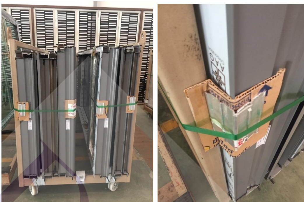
ภาพที่ 4.37 การรัดแผงหน้าต่างกระจกอลูมิเนียมสำเร็จรูป(Window Wall)
