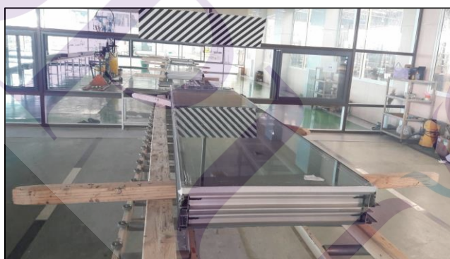
ภาพที่ 3.17 การเคลื่อนแผงเข้าห้อง Clean room
