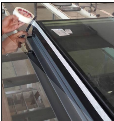
ภาพที่ 3.16 การติดเทปกาวเพื่อป้องกันการเปื้อนเมื่อทำการยิงซิลิโคน
