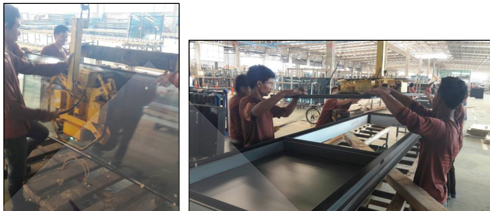
ภาพที่ 3.12 การติดตั้งกระจก
