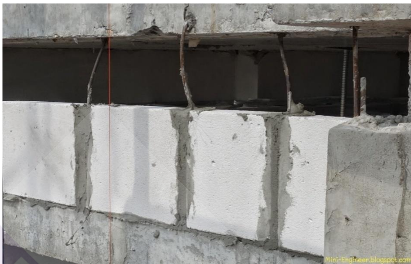
ภาพที่ 2.6 แสดงการก่อคอนกรีตมวลเบา
