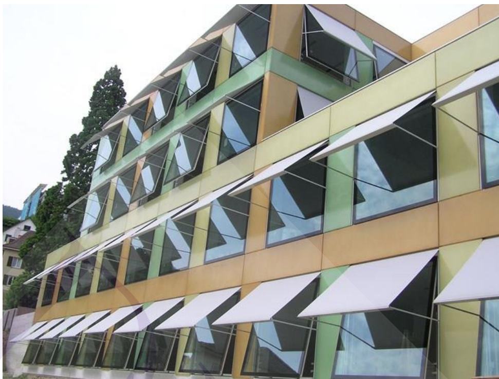
ภาพที่ 2.13 แสดงตัวอย่างการติดตั้งกันแดดบังแดด
