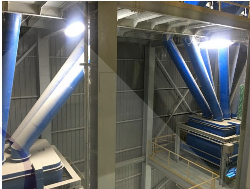
ภาพที่ 3.7 แสดงก่อนการปรับปรุงติดตั้งระบบลำเลียงอาหารจากถังบรรจุอาหารเบ้าท์ ไปยังถังบรรจุอาหารกระสอบ
