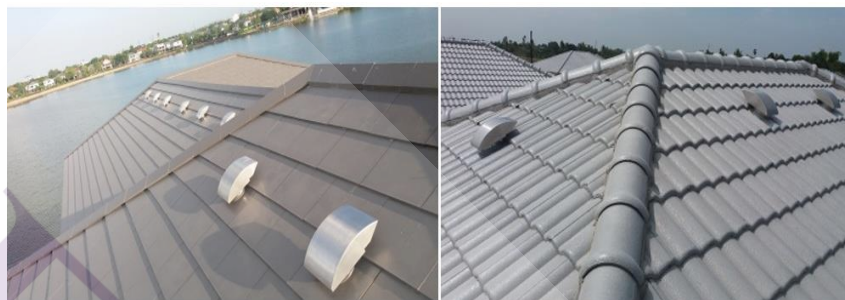
ชุดระบายความร้อนในโถงหลังคา (Solar Roof Tile Ventilator)
