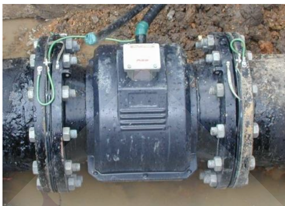
ภาพที่ 2.19 Flow Meter แบบ Electromagnetic และ แบบใบพัด (Turbine)
