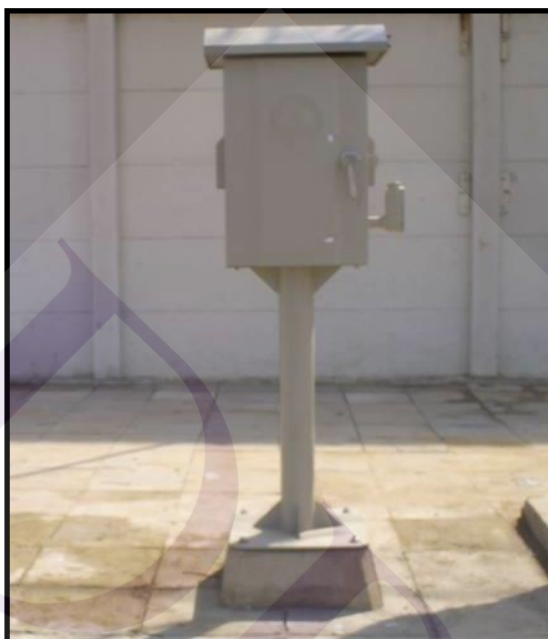
ภาพที่ 2.21 สภาพภายนอกตู้ RTU และท่อ PB เชื่อมต่อ Pressure Sensor เพื่อวัดแรงดันน้ำ
