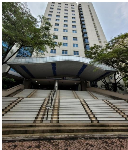
ภาพที่ 3.3 ด้านหน้าที่ตั้งของอาคาร 6
