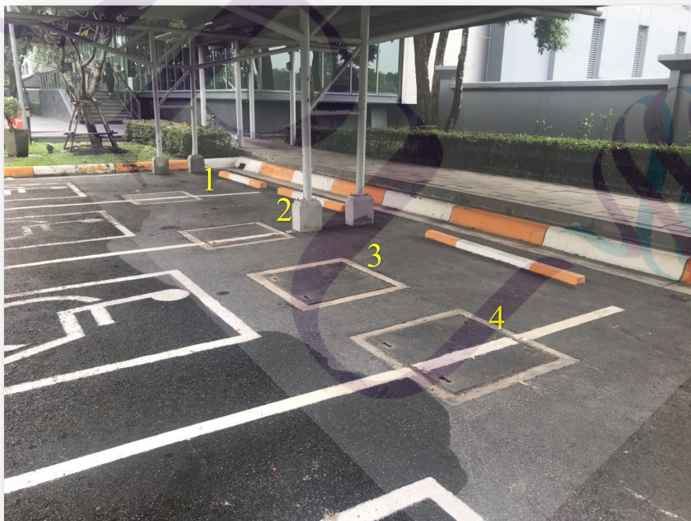
ภาพที่ 3.3 ภาพตำแหน่งของบ่อบำบัดน้ำเสีย บ่อที่ 1-4
