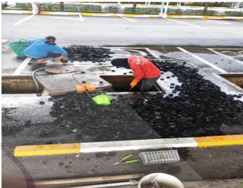
ภาพที่ 4.9 ดำเนินการนำอุปกรณ์ (ลูกมิดี) ขึ้นจากบ่อมาทำความสะอาด
