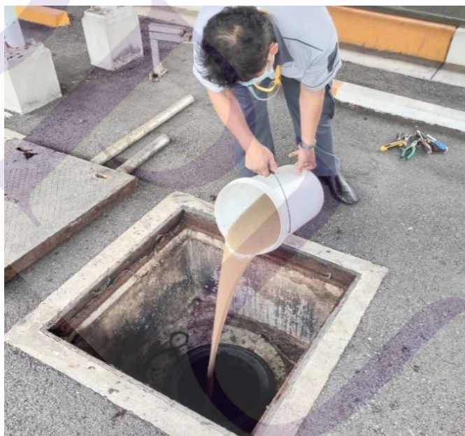
ภาพที่ 4.4 ทำการเติมจุลินทรีย์ลงในบ่อเติมอากาศ
