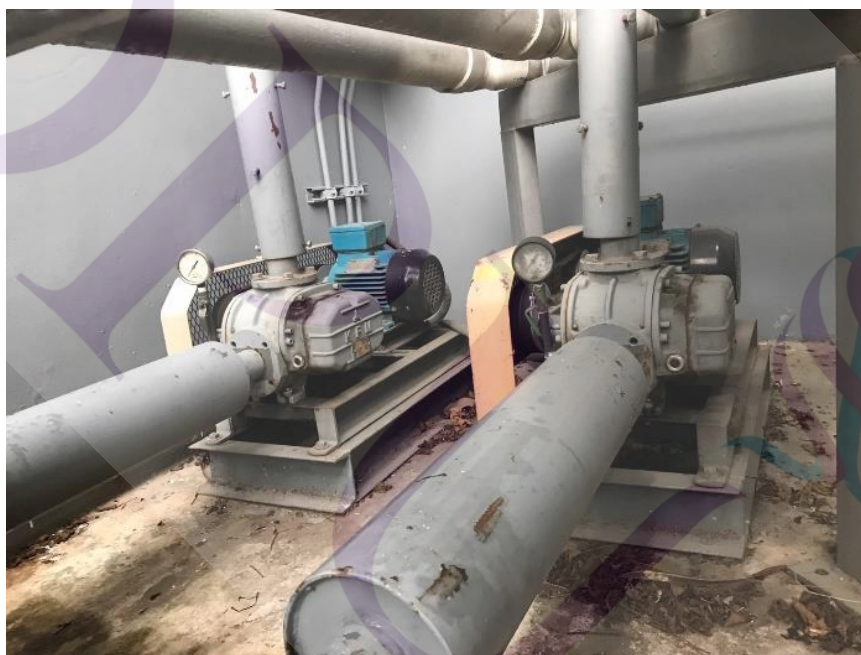
ภาพที่ 4.1 ตรวจเช็คอุปกรณ์ชุดปั๊มอัดอากาศระบบ AirBlower
