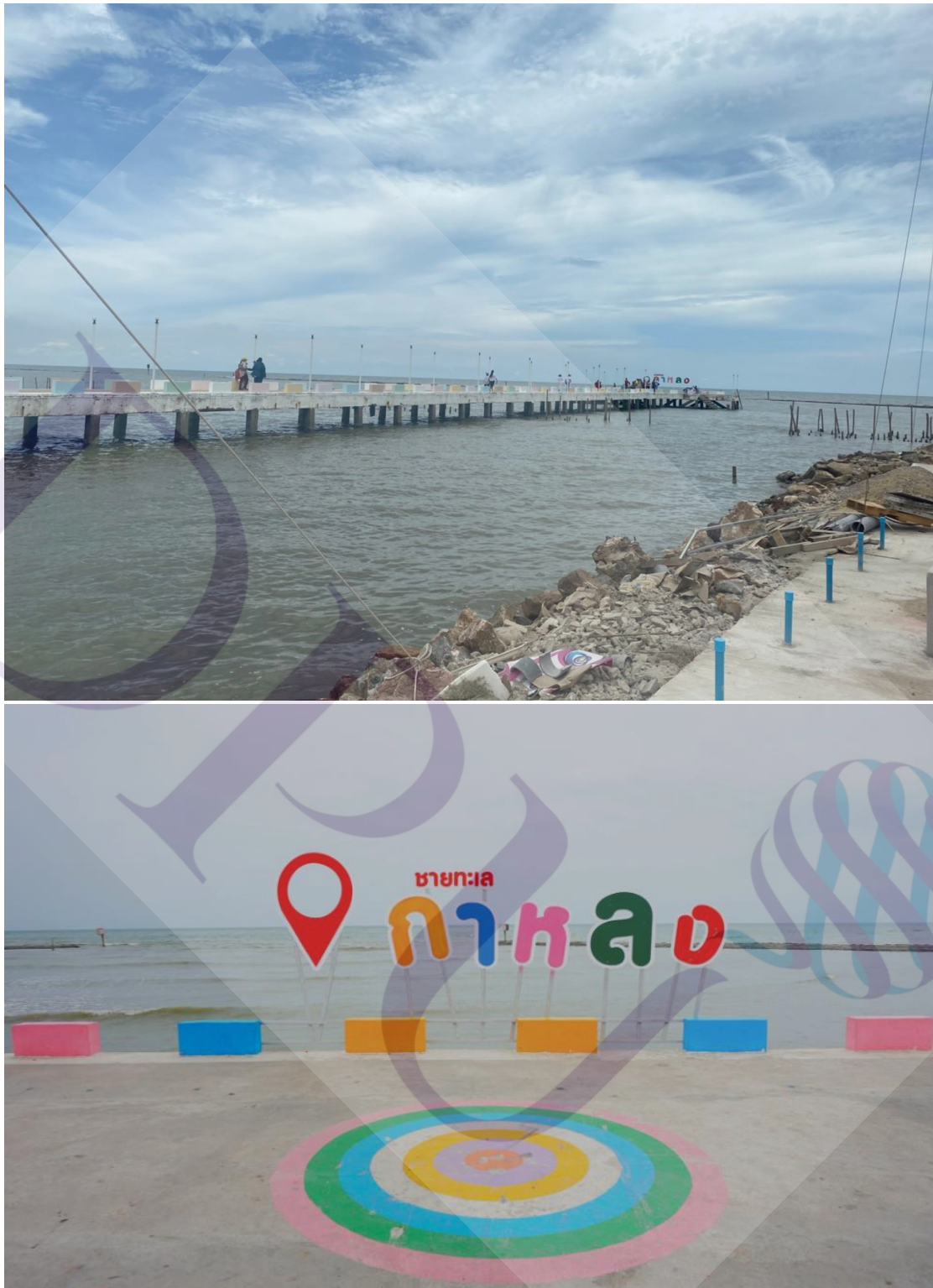
ภาพที่ 2.4 สะพานกาหลง ตำบลกาหลง อำเภอเมืองสมุทรสาคร จังหวัดสมุทรสาคร
