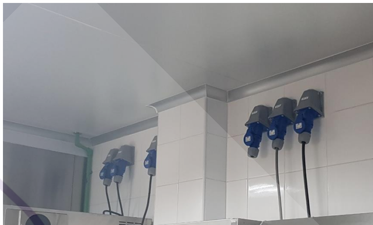
ภาพที่ 3.12 การติดตั้ง Power Plug
