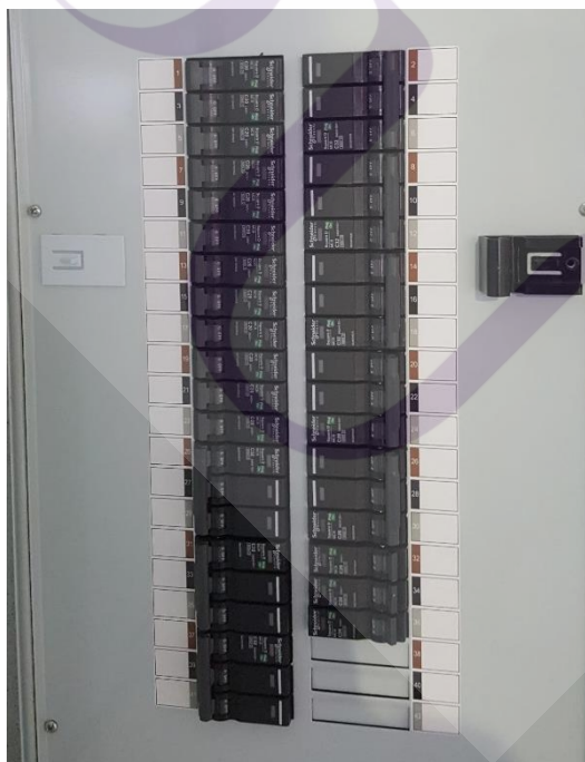
ภาพที่ 3.10 การจัดเรียงลูกเซอร์กิตเบรกเกอร์
