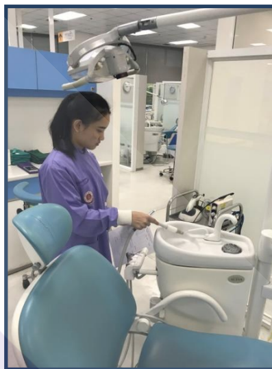
ภาพที่ 4.14 การดูดน้ำทำความสะอาดจากระบบท่อน้ำทิ้ง
