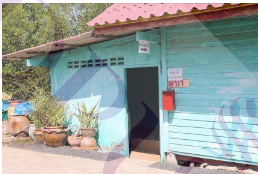
ภาพที่ 4.6 ห้องน้ำที่เปิดให้บริการบริเวณศาลเจ้ากิมทัง
