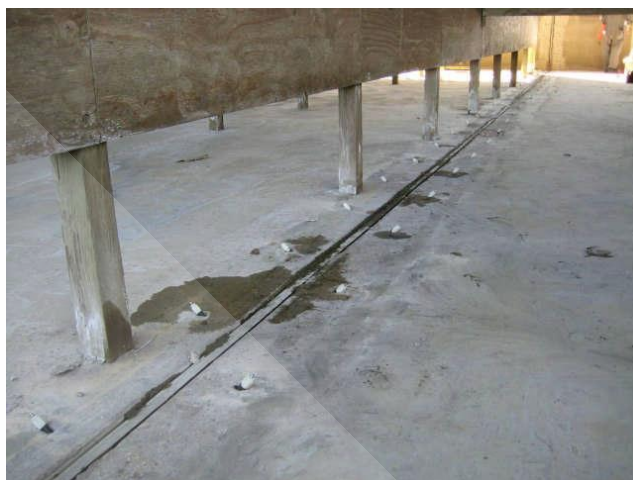
ภาพที่ 2.22 อ่างน้ำเย็น (The cold water basin)
