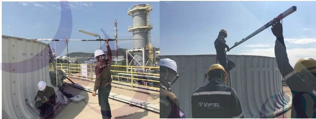
ภาพที่ 4.1 แสดงการวัดอัตราการไหลของลมก่อนเปลี่ยนครั้งสุดท้าย
