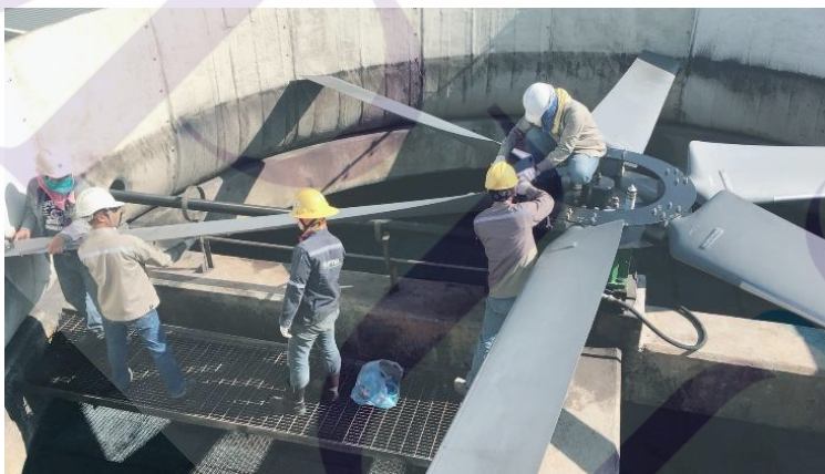
ภาพที่ 4.4 แสดงการประกอบใบพัดชุดใหม่ทั้งหมด 6 ใบเข้ากับดุม
