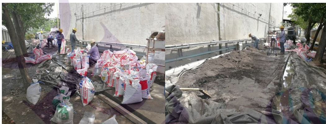
ภาพที่ 4.28 แสดงดิน โคลนที่ถูกล้างซึ่งแสดงให้เห็นว่ามีดิน โคลนปนเปื้อนอยู่ในระบบน้ำหล่อเย็น
