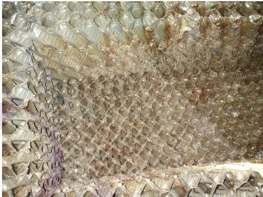
ภาพที่ 4.13 แสดงดิน โคลนที่อุดตัน เกษะติดที่ผิวไส้หลอดอ่อน
