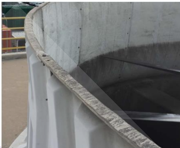
ภาพที่ 4.20 ปล่องลมที่ไม่ได้ทำการออกแบบในรูปแบบเสริมความแข็งแรง
