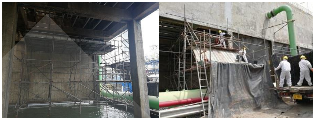
ภาพที่ 4.11 แสดงการตั้งนั่งร้านและการเริ่มรื้อไส้ห่อล่อเย้นออกเพื่อทำความสะอาด
