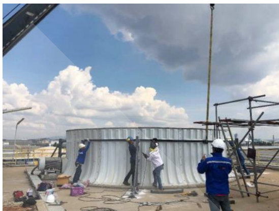
ภาพที่ 4.22 แสดงการติดตั้งโครงสร้างเหล็กรัดกับปล่องลมเพื่อลดการสั่นสะเทือน
