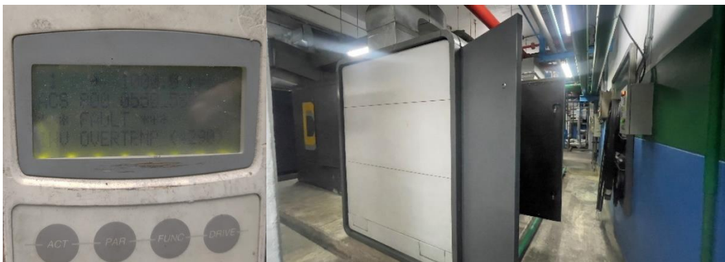
ภาพที่ 4.1 ปัญหาอุณหภูมิมอเตอร์สูง (Motor Over Temperature)
