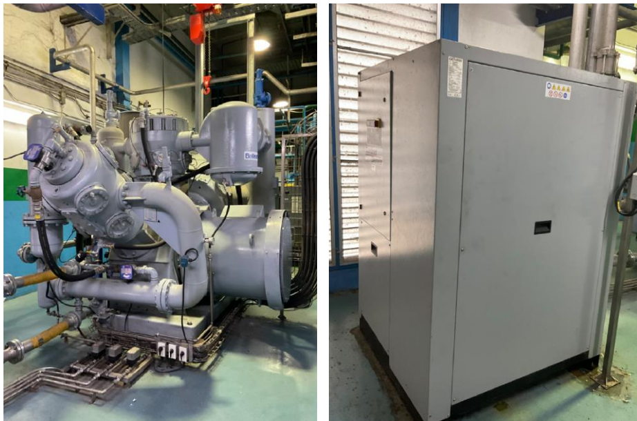
ภาพที่ 3.5 เครื่องอัดอากาศ WH50 และเครื่องทำอากาศแห้ง
