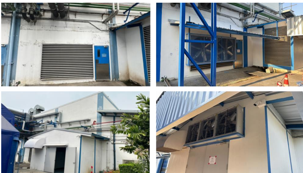
ภาพที่ 4.17 เปรียบเทียบการปรับปรุงระบบระบายอากาศ ก่อนและหลังการปรับปรุง
