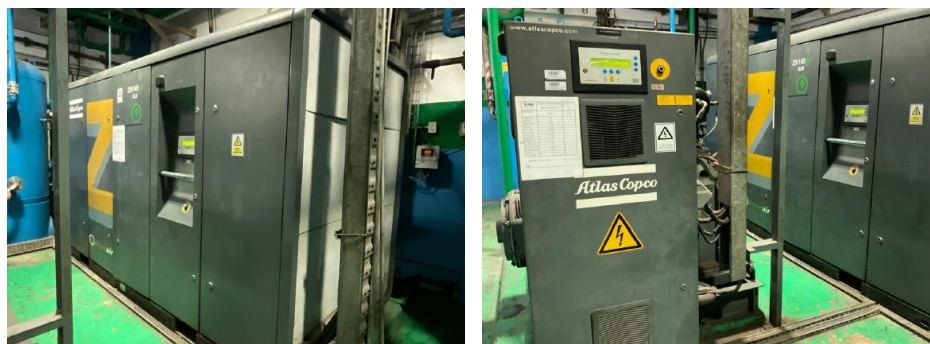
ภาพที่ 3.4 เครื่องอัดอากาศ ZR145 และ เครื่องอัดอากาศ PP1100
