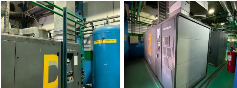
ภาพที่ 3.3 เครื่องอัดอากาศ ZR315-01 และ เครื่องอัดอากาศ ZD2800-01
