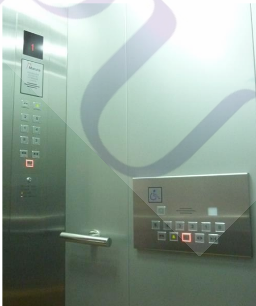
ภาพที่ 3.3 ลิฟต์สำหรับอำนวยความสะดวกสำหรับคนพิการหรือทุพพลภาพ
