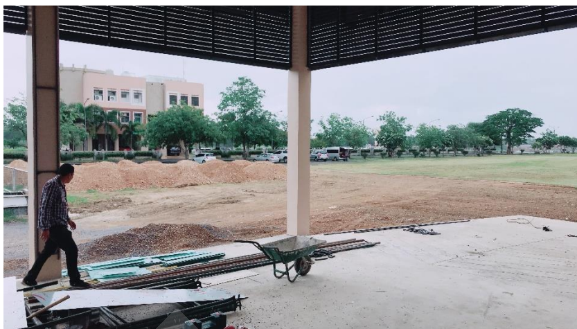
ภาพที่ 3.25 การดำเนินการเริ่มปรับพื้นที่เพื่อเตรียมทำลานจอดรถบริเวณด้านหน้าโครงการ
