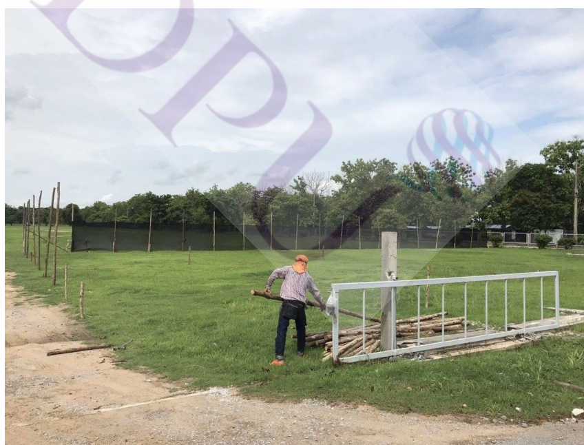
ภาพที่ 3.10 งานจัดเตรียมและเคลียร์พื้นที่เพื่อเตรียมงานก่อสร้าง
