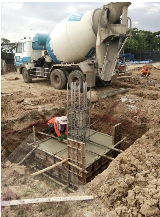
ภาพที่ 3.12 งานจัดทำโครงสร้างงานฐานรากในช่วงเดือนที่ 2
