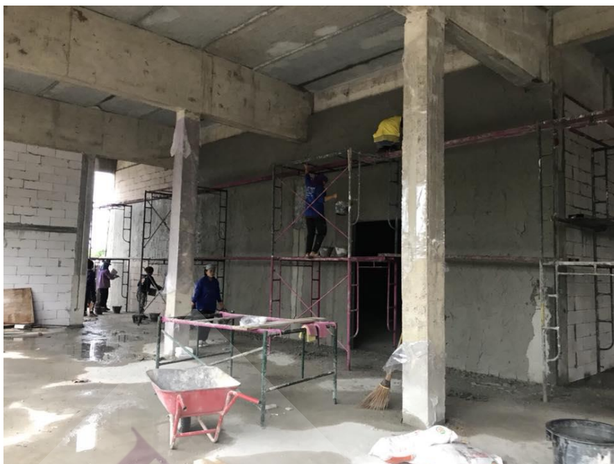
ภาพที่ 3.18 งานก่อและฉาบผนังที่เร่งรัดงานเพื่อเตรียมชิ้นงานระบบไฟฟ้าในเดือนถัดไป
