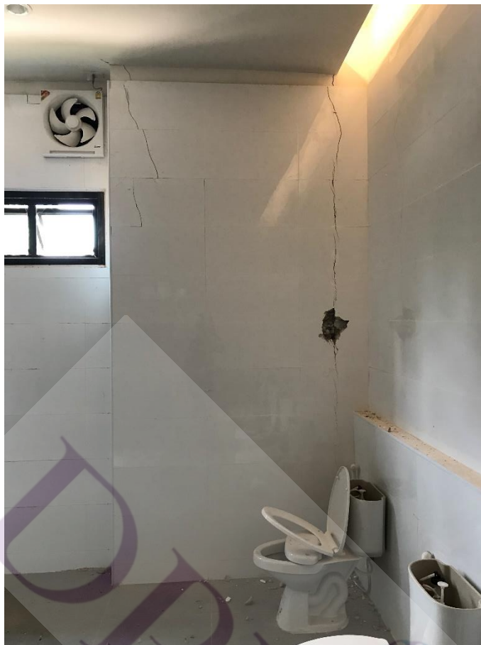
ภาพที่ 3.26 ปัญหาเรื่องผนังร้าวที่เกิดจากการละเลยการตรวจสอบคุณภาพของงาน
