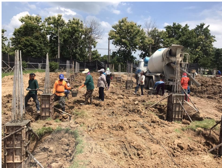
ภาพที่ 3.13 การดำเนินงานในช่วง 2 เดือนแรกที่ปริมาณคนงานค่อนข้างบางตา
