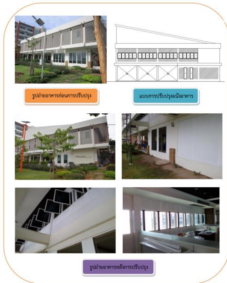
ภาพที่ 3.2 แสดงผนังอาคารก่อนและหลังการปรับปรุง
