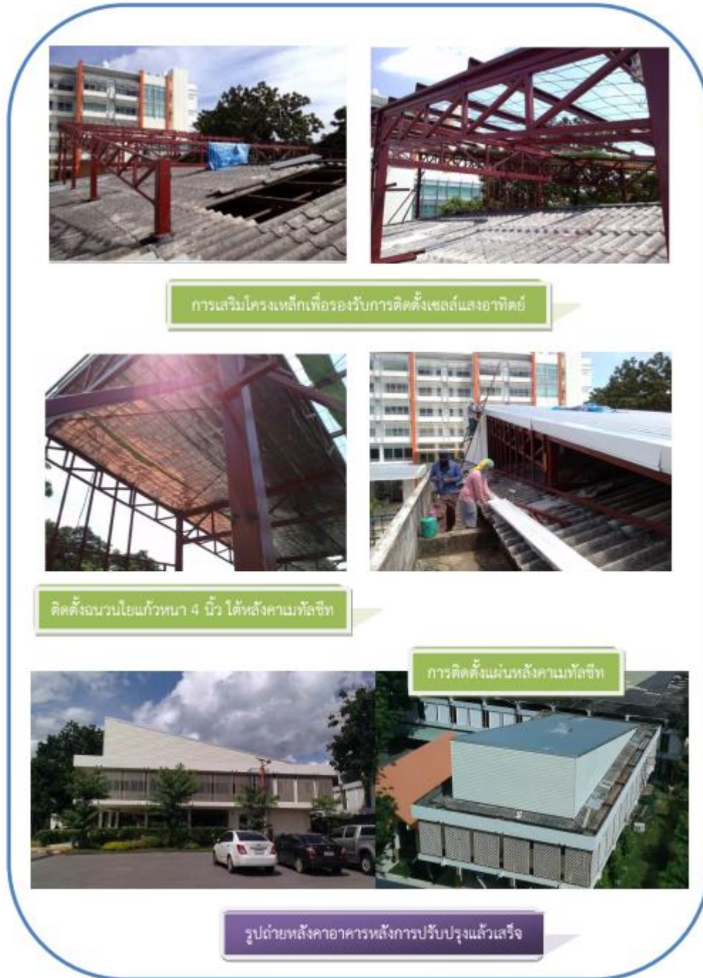
ภาพที่ 3.3 แสดงหลังคาอาคารก่อนและหลังการปรับปรุง
