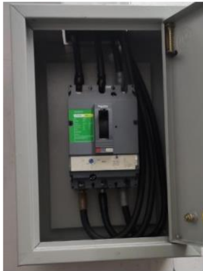
ภาพที่ 3.10 ตู้ควบคุมไฟฟ้ากระแสสลับ (AC Solar Panel)
