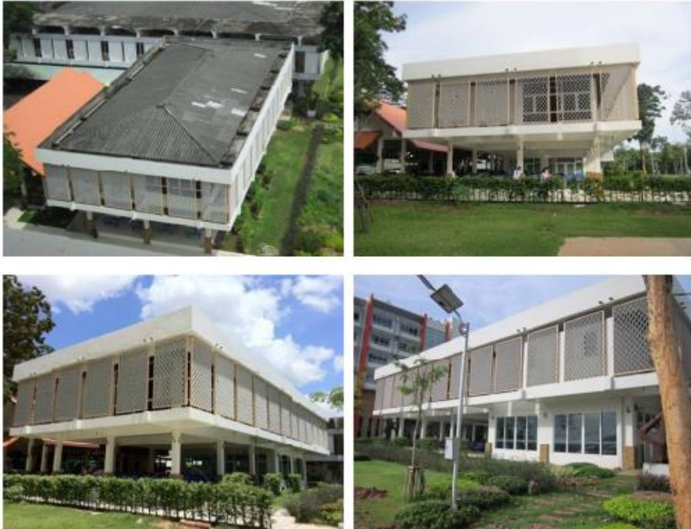
ภาพที่ 3.1 บริเวณด้านนอกอาคารและหลังคาอาคารสำนักงานกองสื่อสารองค์กร
