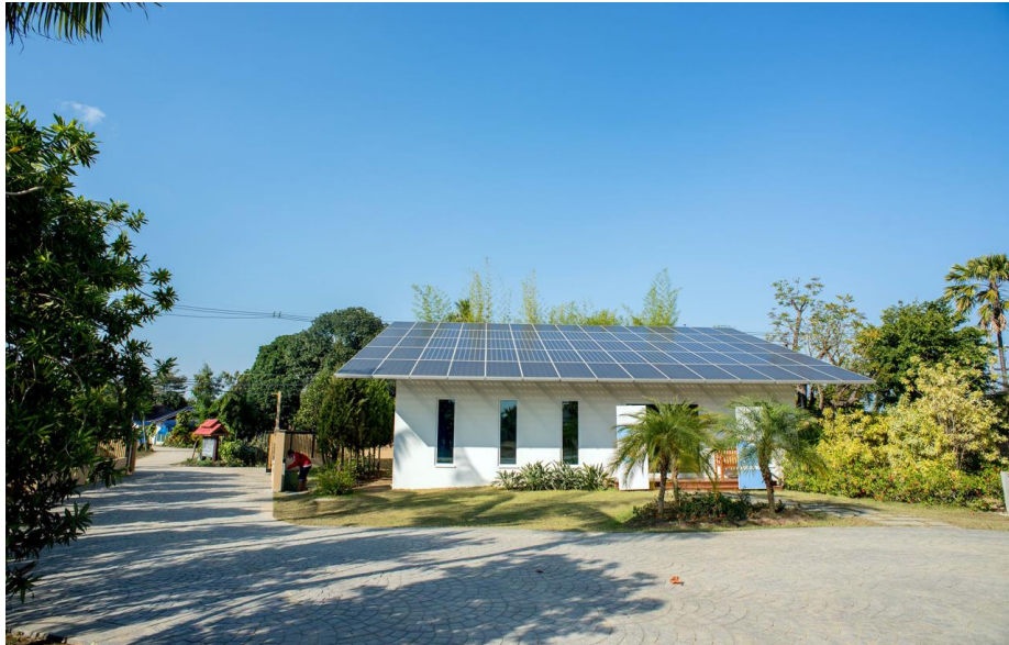
ภาพที่ 3.13 อาคารเก็บพลังงานและผลิตไฟฟ้า
