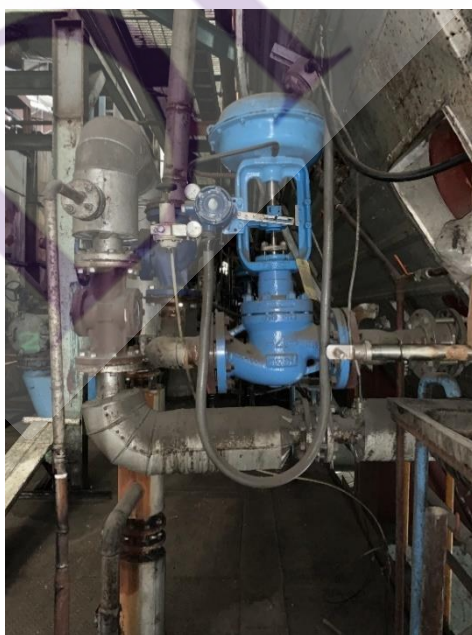
ภาพที่ 4.11 สภาพหม้อต้มหลังติดตั้งระบบไอกวน (Jigger Steam)
