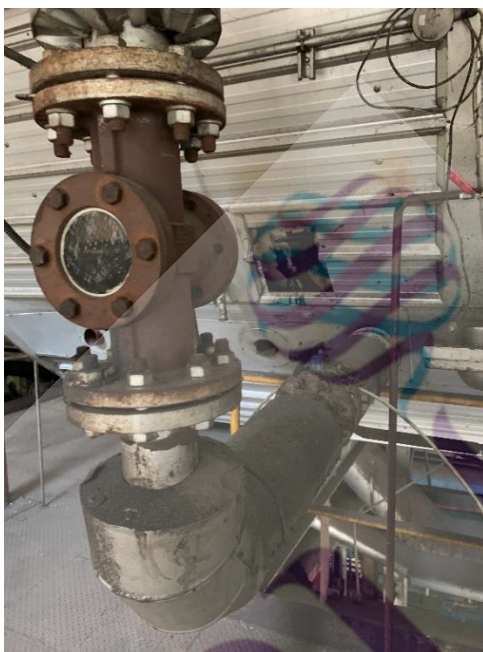
ภาพที่ 4.10 สภาพหม้อต้มก่อนติดตั้งระบบไอกวน (Jigger Steam)
