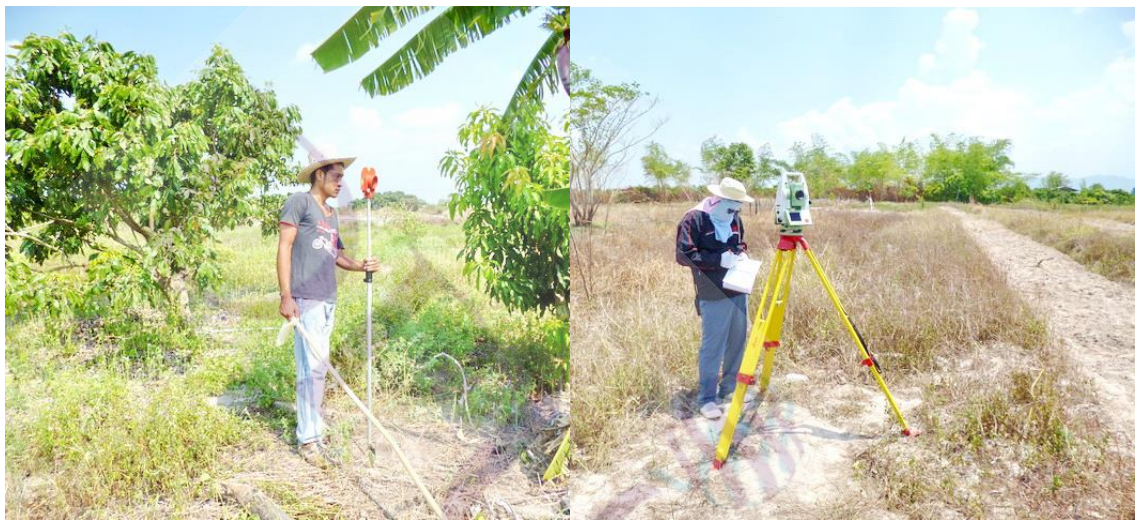
ภาพที่ 4.3 การสำรวจรังวัดหลักหมุดที่ดินด้วยกล้อง Total Station
