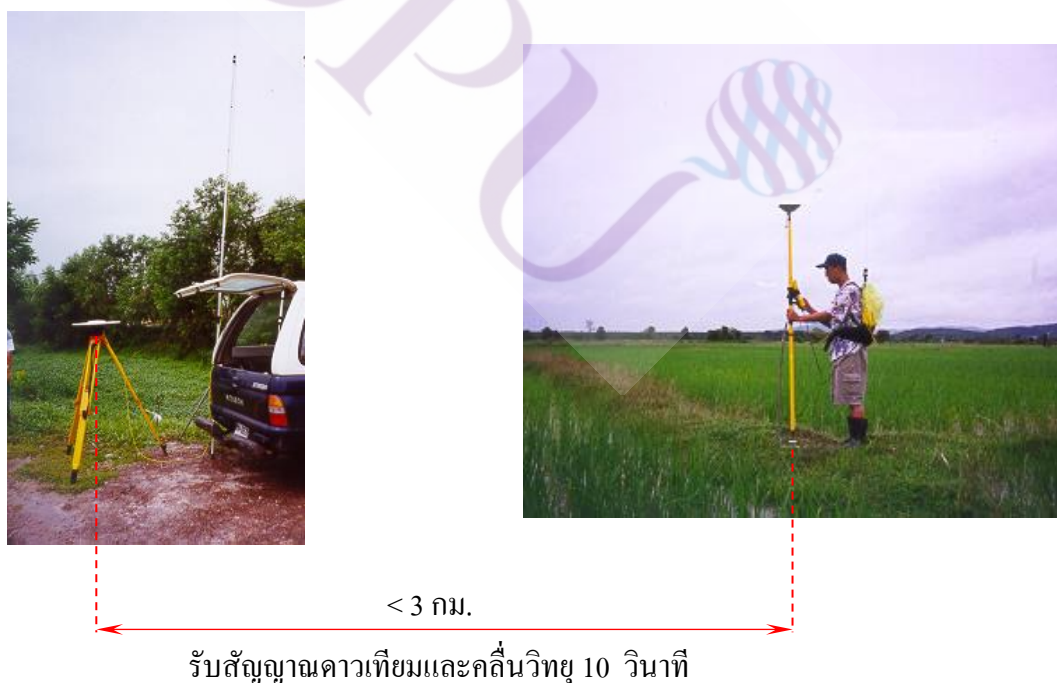
ภาพที่ 4.6 วิธีการสำรวจรังวัดงานแผนที่ชั้นหนึ่งด้วยการรังวัดแบบจลน์ในทันที (RTK) เพื่อเก็บหลักฐานจุดที่ดิน
