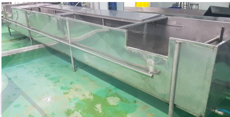
ภาพที่ 4.12 ภาพแสดงเครื่องบ่อหล่อเย็นหลังการปรับปรุง
