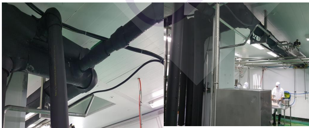
ภาพที่ 4.6 การหุ้มฉนวนท่อน้ำเย็นหลังปรับปรุงฉนวนหุ้มท่อขนาด 20 มม.
