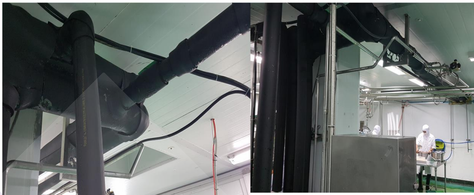
ภาพที่ 3 การหุ้มฉนวนท่อน้ำเย็น
