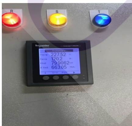
ภาพที่ 4.12 มิเตอร์ไฟฟ้าของอาคารเรียนวิทยาลัยบริหารธุรกิจนวัตกรรมและการบัญชี
