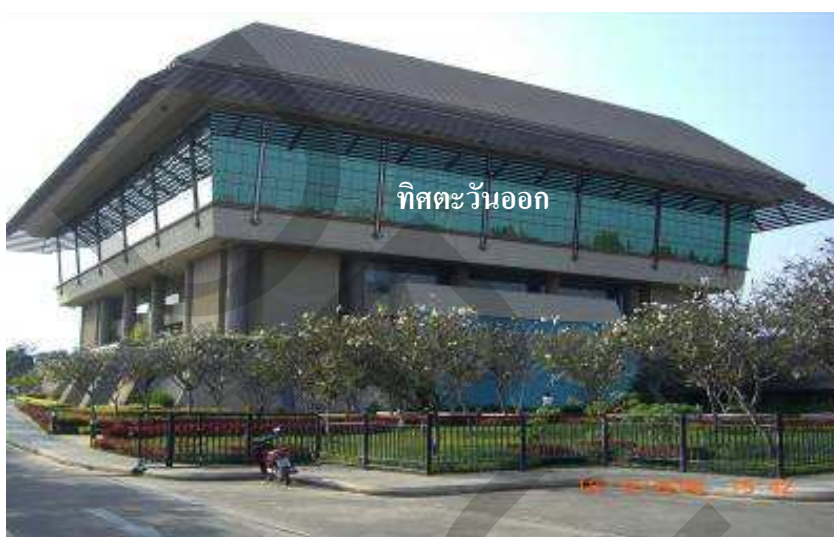
รูปที่ 4.12 ลักษณะพื้นที่ด้านทิศตะวันออกของอาคารสำนักงาน
