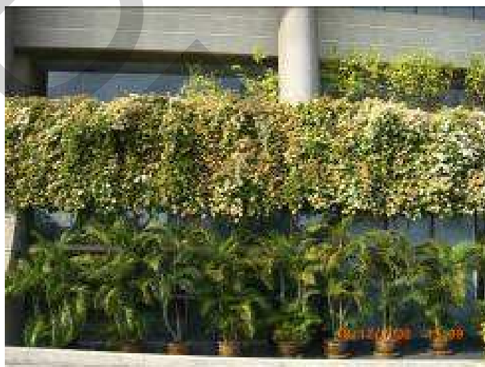
รูปที่ 4.11 การใช้ต้นไม้ลดความร้อนเข้าอาคาร บริเวณชั้นล่างของอาคารด้านทิศใต้
