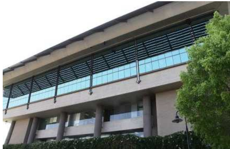
รูปที่ 4.1 ลักษณะพื้นที่ทางด้านทิศเหนือของอาคาร
