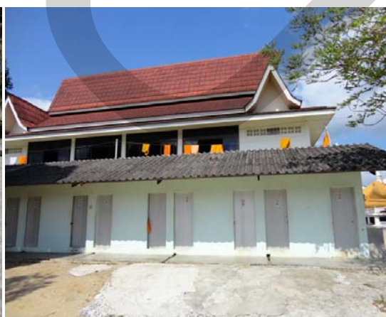
ห้องน้ำภายในบริเวณวัด
