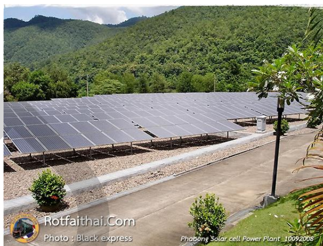
รูปที่ 2.5 โรงไฟฟ้าเซลล์แสงอาทิตย์ผาบอง 500kW จังหวัดแม่ฮ่องสอน
