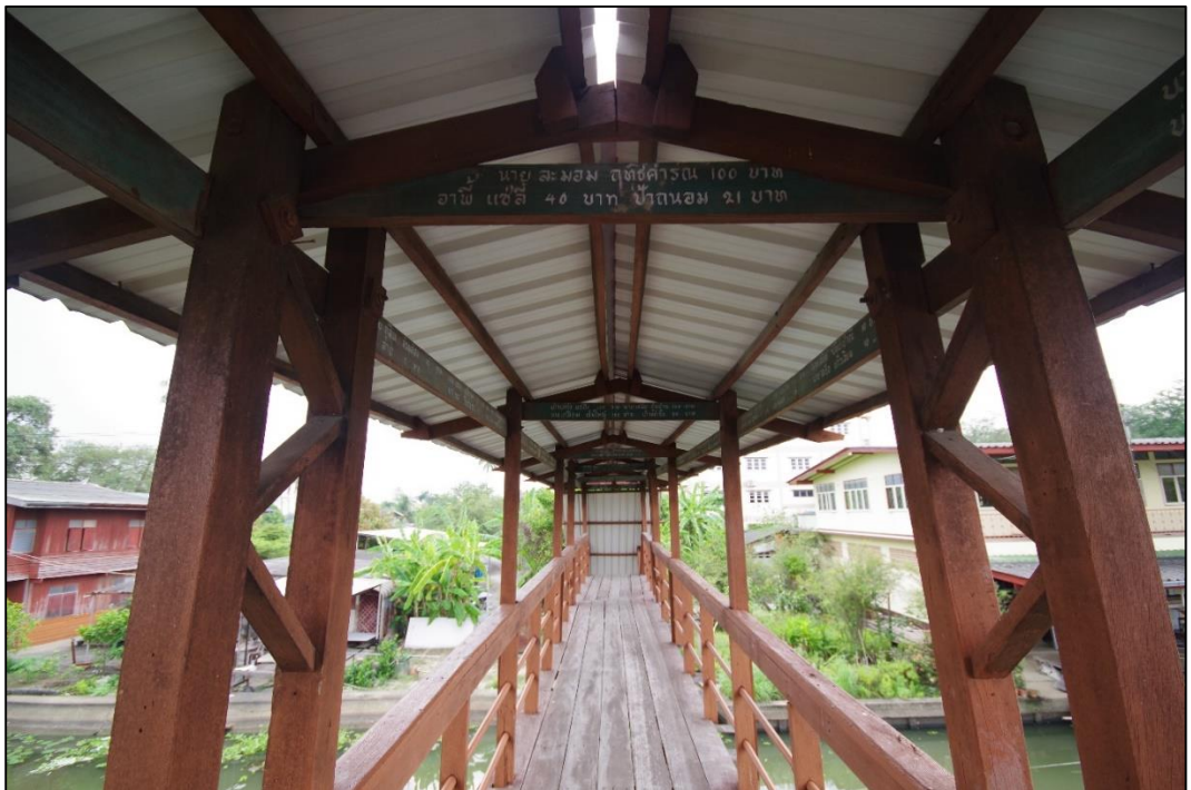
ภาพที่ 4.24 บนสะพานมีการลงชื่อและจำนวนเงินบริจาคเพื่อการสร้างและซ่อมแซมสะพานไม้ไว้ ตามส่วนต่างๆ ของสะพาน
