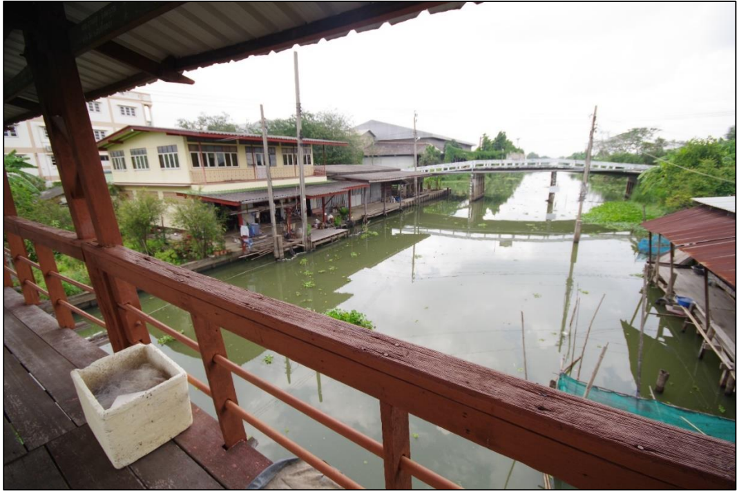
ภาพที่ 4.23 มุมมองจากบนสะพานไม้ไปยังสะพานปูนปากคลองบางใหญ่บรรจบกับคลอง นราภิรมย์ และ คลองโยง อำเภอพุทธมณฑล จังหวัดนครปฐม
