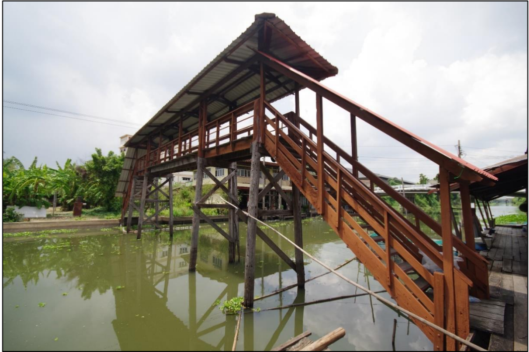
ภาพที่ 4.25 สะพานไม้หลังการซ่อมแซมมาไม่นาน แต่ยังเห็นเสาไม้เก่าดั้งเดิมอยู่บ้าง
