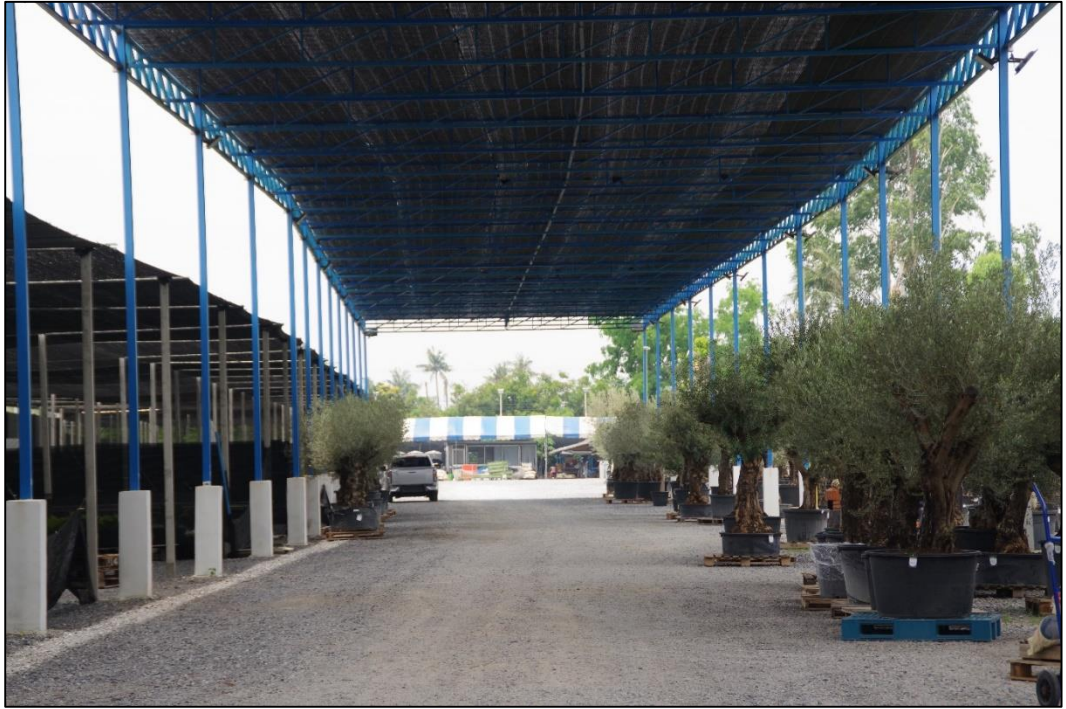
ภาพที่ 4.43 ภายในตลาดยังมีร้านค้าน้อยเนื่องจากเพิ่งเปิดไม่นาน
