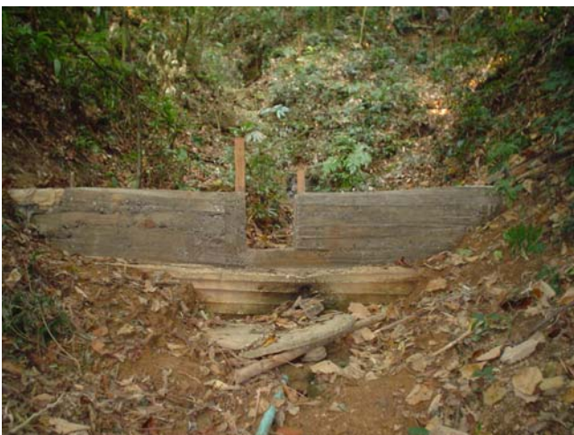
ฝายกั้นถาวรบ้านแครง ซ่องกลางฝายนั้น ชาวบ้านสร้างไว้เพื่อใช้ไม้มาเสริมในการ กั้นน้ำและตะกอน ทำให้ได้ระดับน้ำสูงขึ้น จนทานแรงน้ำไม่ได้ ก็จะหักกลายเป็น ทางน้ำผ่านปกติ
