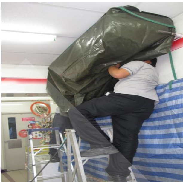
ภาพที่ 3.3 การล้างทำความสะอาดเครื่องปรับอากาศในร้านสะดวกซื้อ
