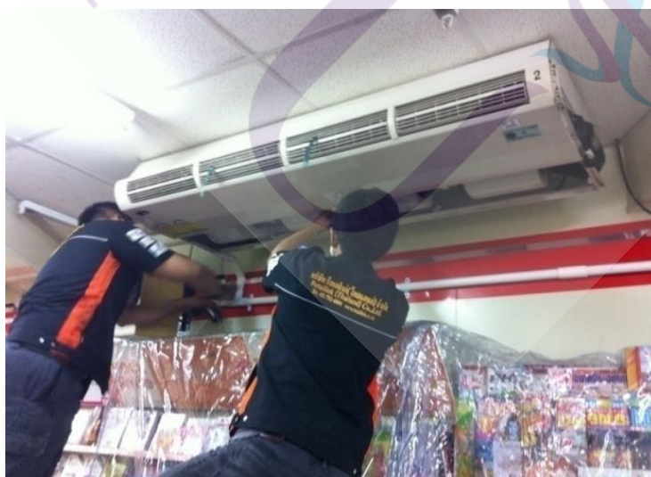
ภาพที่ 3.2 ลักษณะเครื่องปรับอากาศที่ติดตั้งในร้านสะดวกซื้อ
