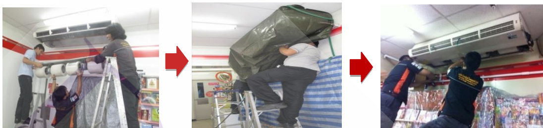
ภาพที่ 1.1 แสดงขั้นตอนการล้างทำความสะอาดเครื่องปรับอากาศ
