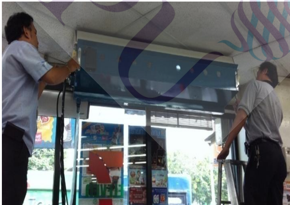
ภาพที่ 4.1 การติดตั้งเครื่องเครื่องล้างเครื่องปรับอากาศกับตัวเครื่องปรับอากาศ
