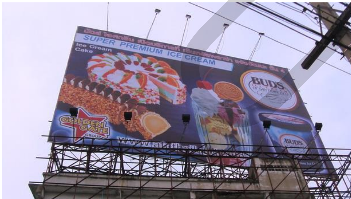
ภาพที่ 2.2 ป้ายโครงถัก (2)
