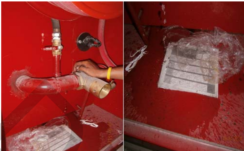
ภาพที่ 4.7 น้ำรั่วซึมจากจุดต่อวาล์วน้ำ
