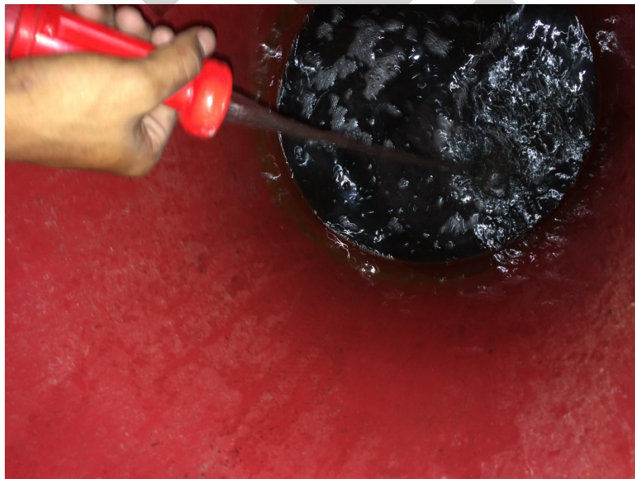
ภาพที่ 6 การทดสอบการเปิด-ปิด หัวฉีดน้ำดับเพลิง
