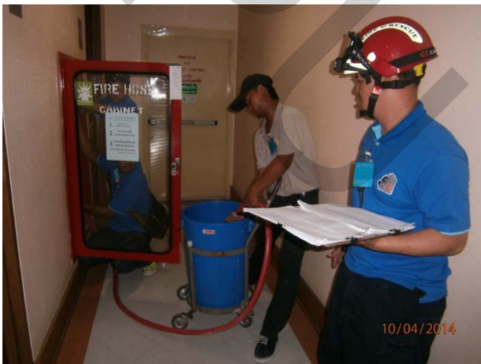
ภาพที่ 8 การตรวจเช็คความพร้อมของการใช้งานตู้สายฉีดน้ำดับเพลิงแบบสายยาง
