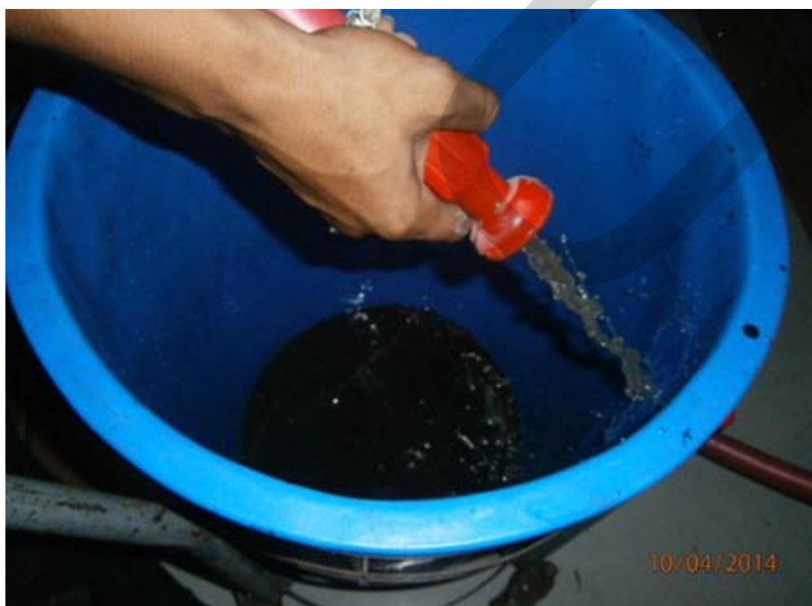
ภาพที่ 4.13 หัวฉีดดับเพลิงขนาด 1 นิ้ว ที่ปิดน้ำไม่ได้
