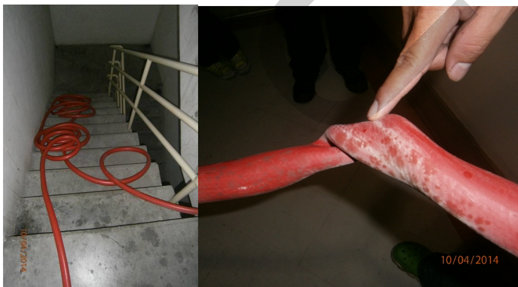
ภาพที่ 4.17 สายฉีดน้ำดับเพลิงขนาด 1 นิ้วที่มีร่องรอยการถูกกดทับ
