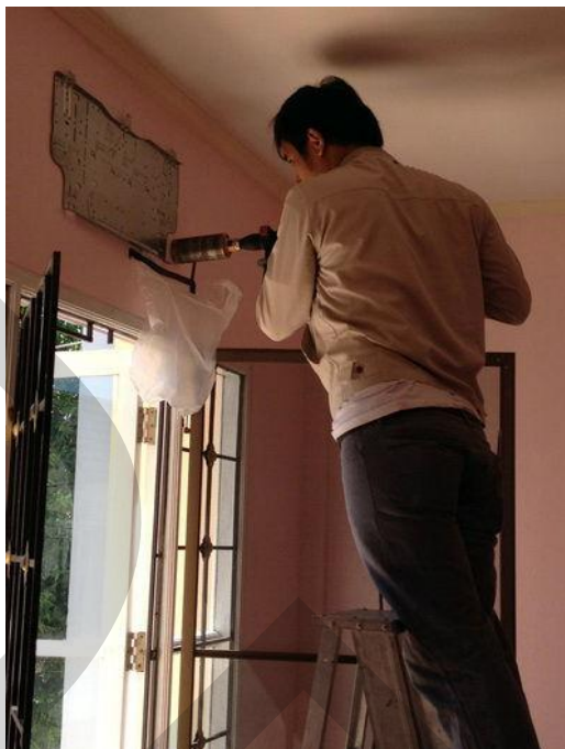
ภาพที่ 0.3 ผู้ติดตั้งนอกของบริษัท A ใช้สว่านเจาะกำแพงพร้อมใช้ถุงในการเก็บฝุ่น
