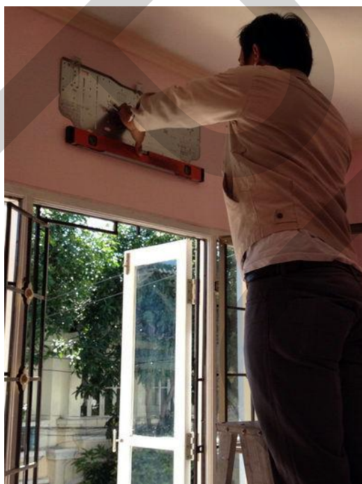
ภาพที่ 0.2 ผู้ติดตั้งนอกของบริษัท A ทำการวัดระดับก่อนทำการติดตั้ง ป้องกันการเอียง
