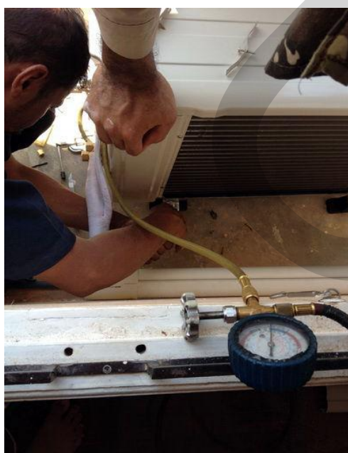
ภาพที่ 0.10 ผู้ติดตั้งของบริษัท E ขณะทำการการแวกคัมเพื่อไล่ความชื้นในท่อ
