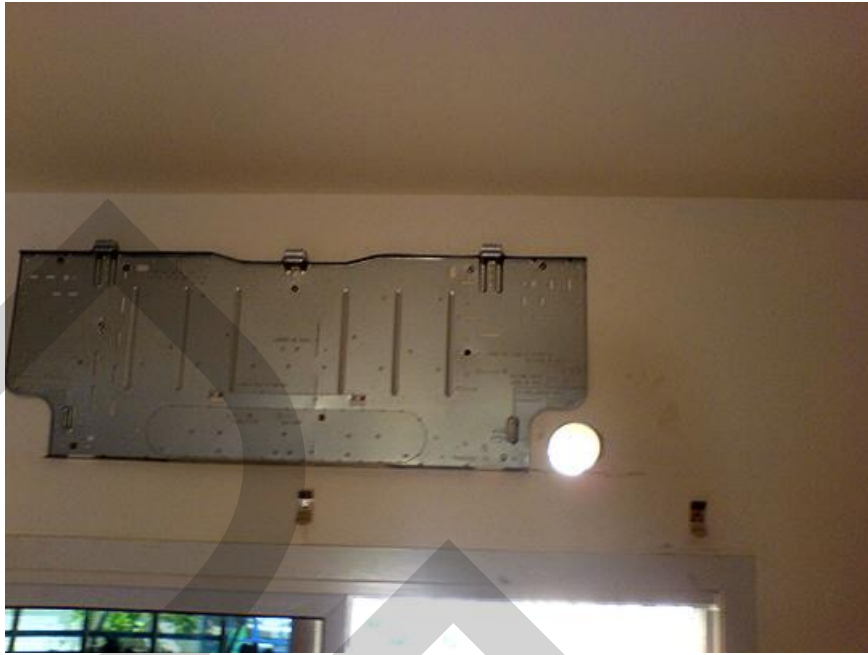
ภาพที่ 0.5 ช่องสำหรับท่อน้ำที่เกิดจากการเจาะ โดยใช้ไฮลเซอร์
