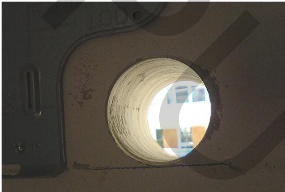
ภาพที่ 0.6 ความเรียบของช่องจากการใช้อุปกรณ์ที่มีคุณภาพ
