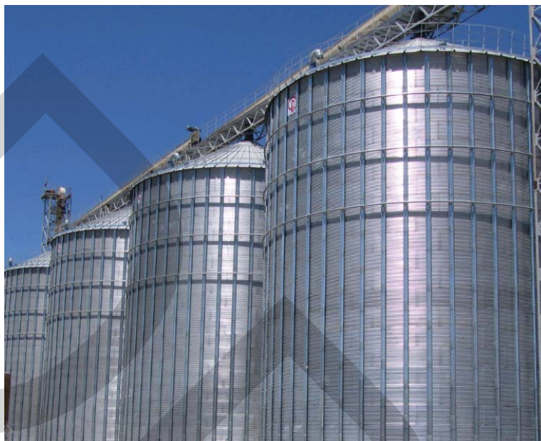
ภาพที่ 3.4 Silo พักเศษไม้ Chipper
