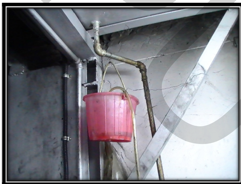
ภาพที่ 10 ท่อน้ำมันรั่ว
