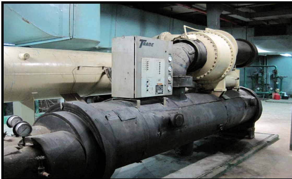
ภาพที่ 2.2 การเปลี่ยนเครื่องทำน้ำเย็น (Chiller) ที่ใช้สาร ซีเอฟซี
