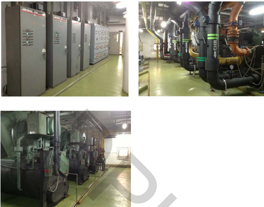
ภาพที่ 1.1 สภาพเครื่องทำน้ำเย็น (Chiller) เครื่องปัจจุบันขนาด 500 ตันความเย็นของอาคาร
