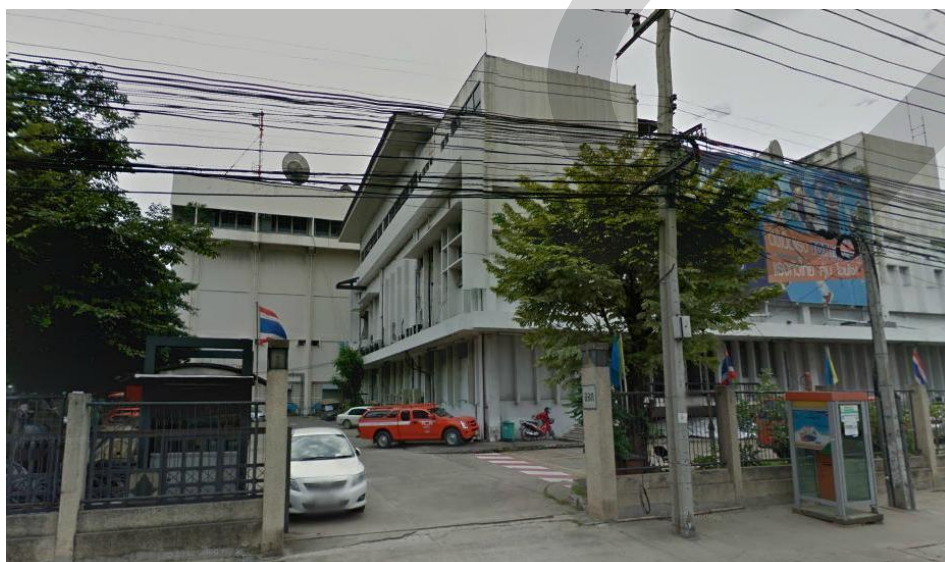
รูปที่ 3.2 ลักษณะตัวอาคารชุมสายโทรศัพท์หลักสี่
