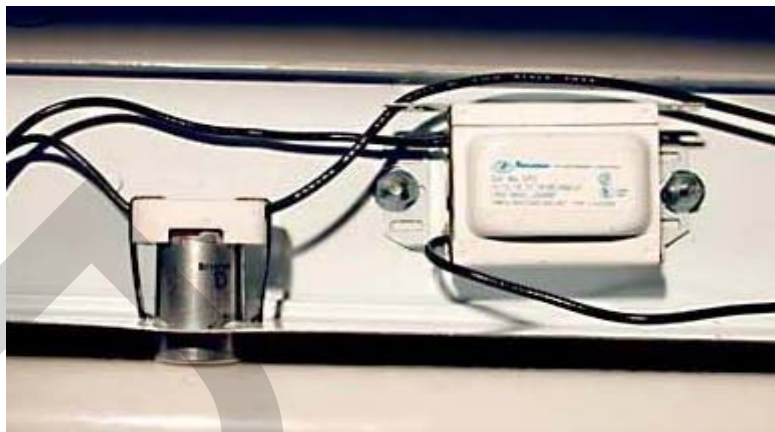
รูปที่ 2.13 การต่อสายสาร์ทเตอร์เข้ากับบัลลาสต์
