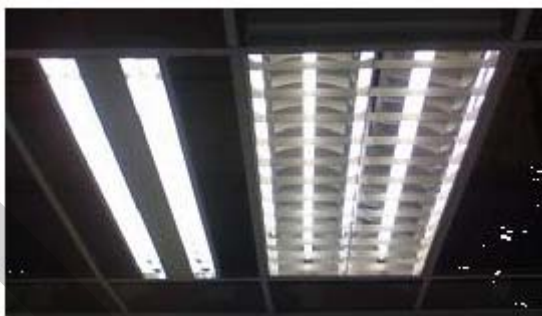
รูปที่ 2.5 เปรียบเทียบรูปการจจัดวางโคมหลอด T5 และ โคมหลอด TLD ในพื้นที่สำนักงาน
