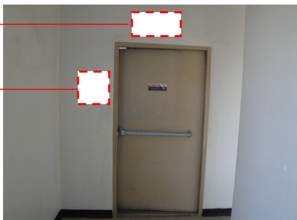
ภาพที่ 4.19 จุดติดตั้งป้ายบอกชั้นและป้ายบอกทางหนีไฟภายนอกประตูหนีไฟ
