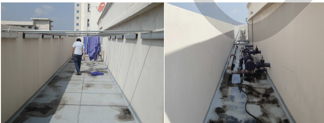
ภาพที่ 4.3 สิ่งกีดขวางทางหนีไฟบนชั้นคานไฟฟ้า
