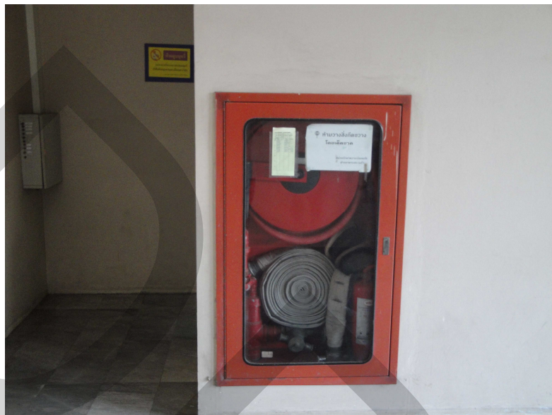
ภาพที่ 4.12 ตู้หัวฉีดน้ำดับเพลิง
