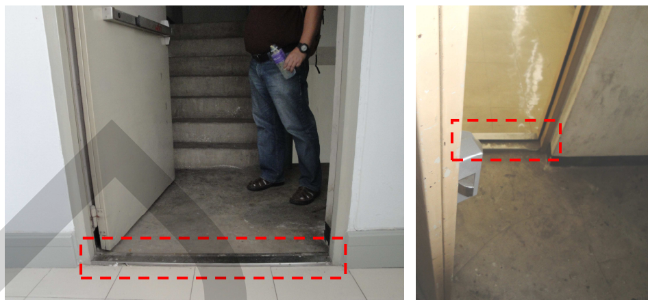
ภาพที่ 4.21 ธรณีประตูบริเวณประตูหนีไฟ
