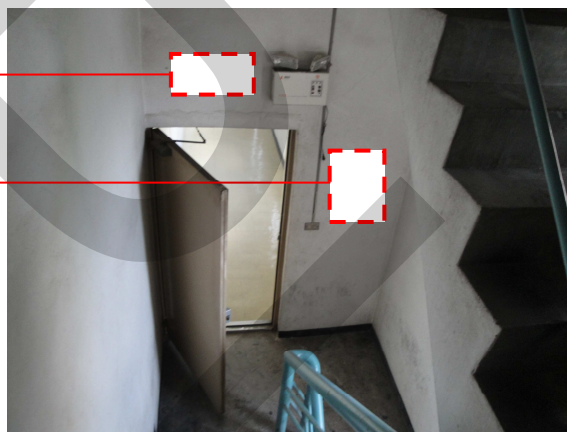
ภาพที่ 4.20 จุดติดตั้งป้ายบอกชั้นและป้ายบอกทางหนีไฟภายในประตูหนีไฟ
