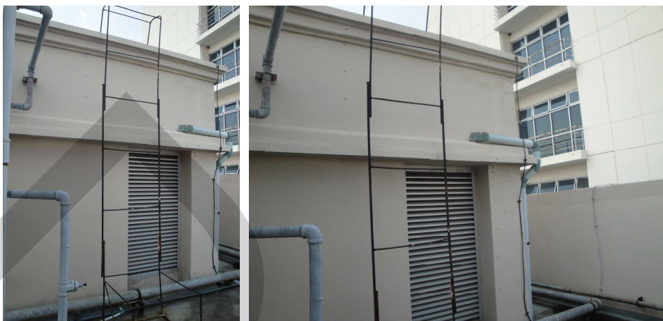
ภาพที่ 4.2 ทางขึ้นไปยังพื้นที่บนคานไฟฟ้าขนาดกว้าง ยาว ด้านละไม่น้อยกว่า 10.00 เมตร
