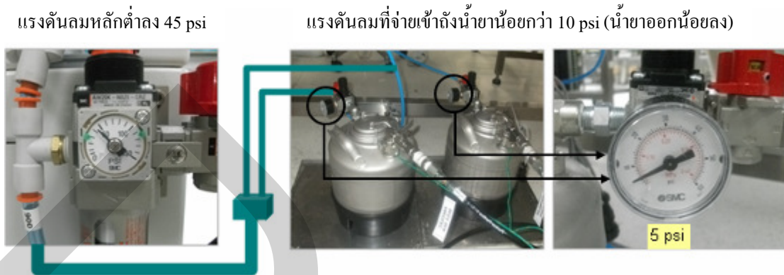
รูปที่ 4.11 แสดงแรงดันลมหลักต่ำลง ทำให้แรงดันลมที่จ่ายเข้าถึงน้ำยาน้อยกว่า 10 psi (น้ำยาน้อย)
