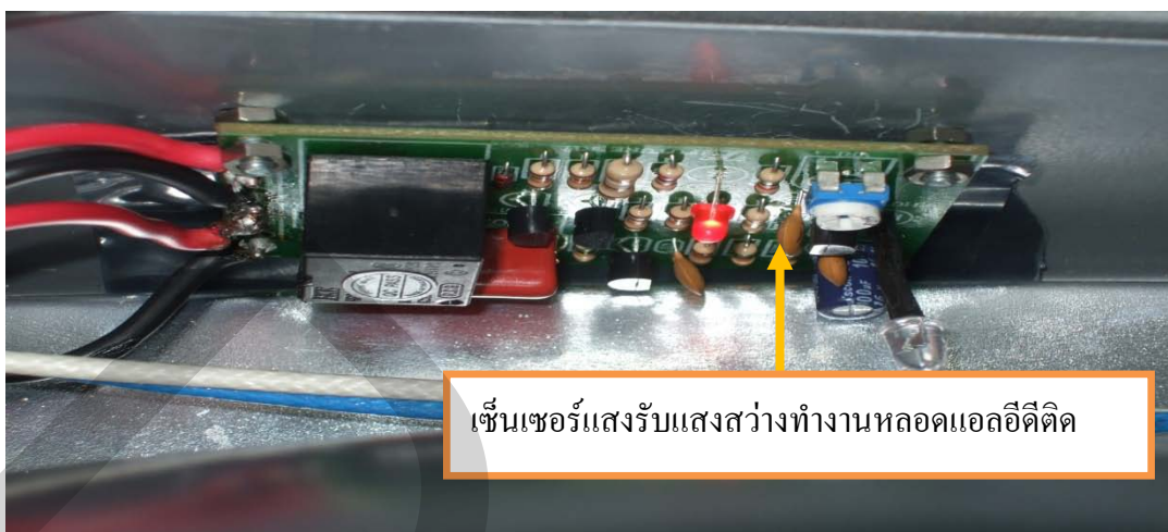
ภาพที่ 4.5 การทำงานของ โคมไฟฟาส่องสว่างเซ็นเซอร์ไฟได้ไดโอดรับแสงสว่างหลอดแอลอีดีติด
