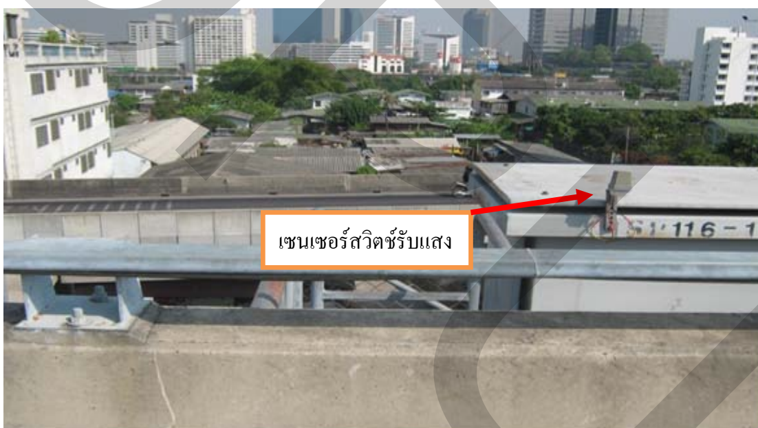
ภาพที่ 2.2 ผู้ควบคุมและเซนเซอร์สวิตช์รับแสงสั่งการทำงาน เปิด-ปิด โคมไฟส่องสว่าง
