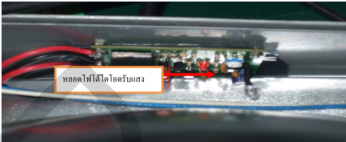
ภาพที่ 4.3 บอร์ดเซนเซอร์ไฟได้ไดโอดที่ติดตั้งในโคมไฟส่องสว่าง
