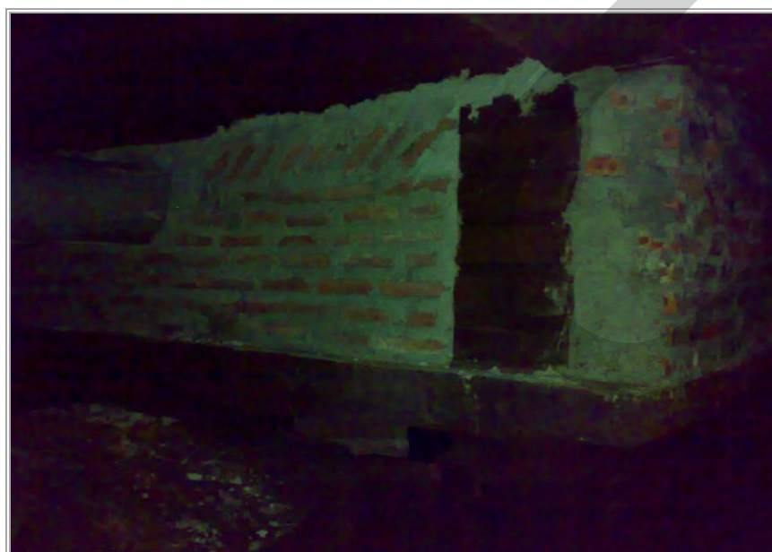
ภาพที่ 4.12 ส่วนที่ทำการปรับปรุง (D) ที่ก่ออิฐปิดไม่ให้ควันเข้า
