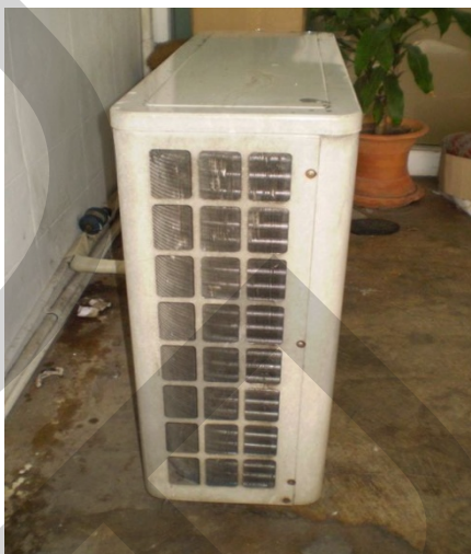
ภาพที่ 4.1 Condenser ด้านหลังก่อนทำการติดตั้งอุปกรณ์ระบายความร้อน
