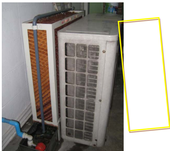
ภาพที่ 4.2 Condenser ที่ทำการติดตั้งอุปกรณ์ระบบ Cooling Pack
