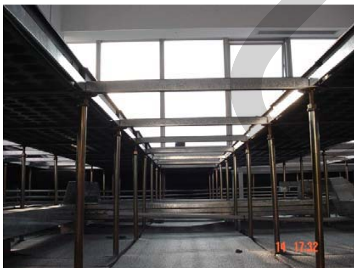
รูปที่ 2.2 พื้นยกและรางเดินสายใต้พื้นยกสูง 50 cm แบบมีคาน (Stringer) ทั้ง 4 ด้าน
