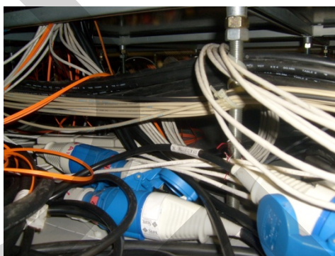
รูปที่ 4.6 การจัดวางสายระบบสื่อสาร และระบบไฟฟ้าใต้พื้น ห้องคอมพิวเตอร์ B
