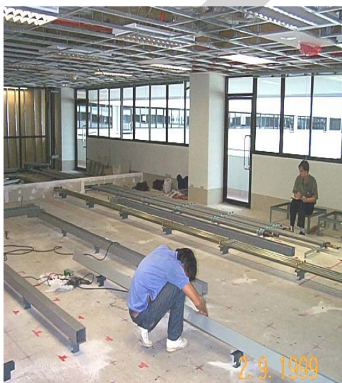
รูปที่ 2.23 รางเดินสาย และการจัดวางให้เหมาะสม
