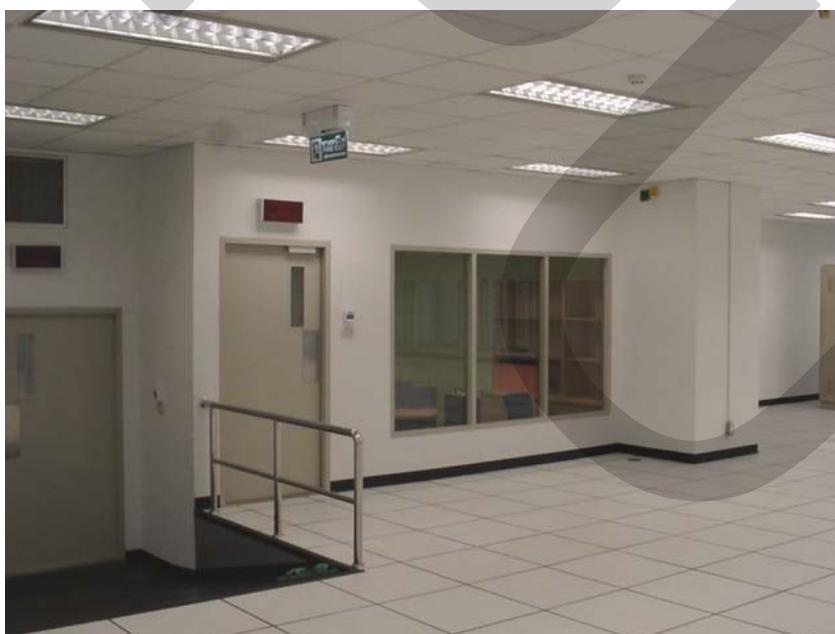
รูปที่ 2.1 ผนังยิปซัม แผ่นฝ้าอะคูสติค กระจกนิรภัยกันความร้อน(Tempered Safet Glass และ ประตูป้องกันไฟ)
