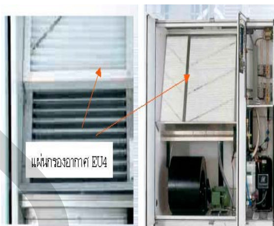
รูปที่ 2.22 แผ่นกรองอากาศที่ติดตั้งระบบปรับอากาศควบคุมความชื้น (Precision air conditioning)
