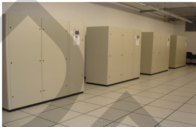
รูปที่ 2.17 ระบบปรับอากาศควบคุมความชื้น (Precision air conditioning) แบบ Down Flow System ที่มา : การออกแบบพื้นที่ศูนย์สารสนเทศ; บริษัท SITEM ประเทศไทย เมื่อ 25 มีนาคม 2548
