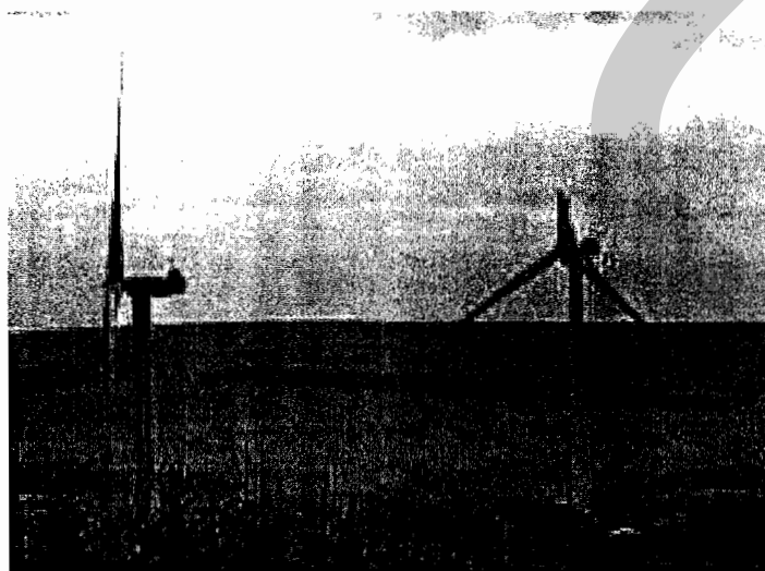
รูปที่ 2.4 ภาพตัวอย่างใบพัดเสียหายเนื่องจากกระแสลมแรง
