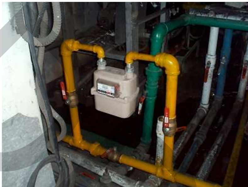
รูปที่ 3.15 การติดตั้งมาตรวัดก๊าซ (Gas meter)
